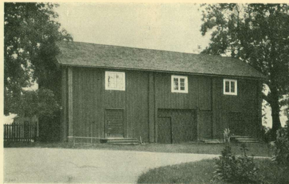
De tre fönsterna i vita ramar på jämna avstånd skänka en förträfflig rytm åt den vackra stommen. Om även de olikformade portöppningarna på nutida vis inramats i vitt, hade det goda intrycket gått helt förlorat.
