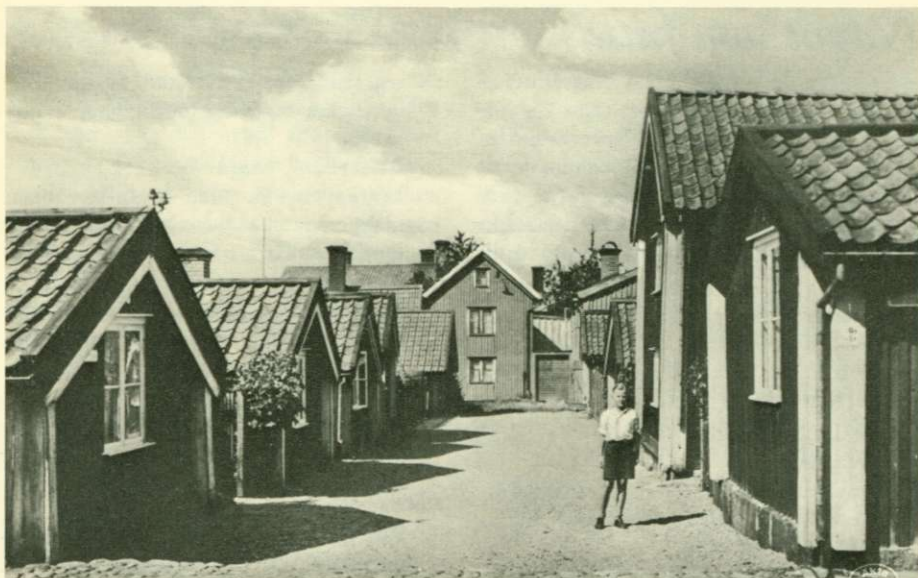
Båtsmansstugorna i Västervik är ett levande minnesmärke från en förgången tid. Det är viktigt att foga in detta i en modern stadsbild.
