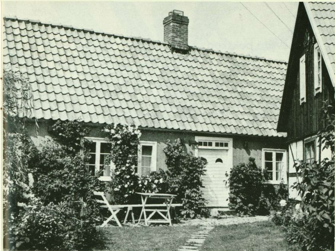
Ett fint exempel på en restaurerad byggnad, som var i fara att bli "bortrationaliserad"
