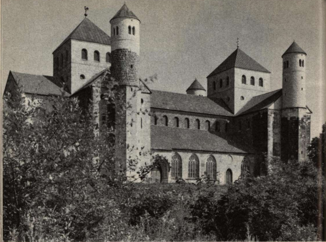
Restaureringen av S:t Michael i Hildesheim är ett intressant exempel på hur man skickligt återfört arkitekturen till dess ursprungliga stil. Det svårt skadade byggnadsverket har i sitt restaurerade skick ingen likhet med exteriörens utseende före kriget.
