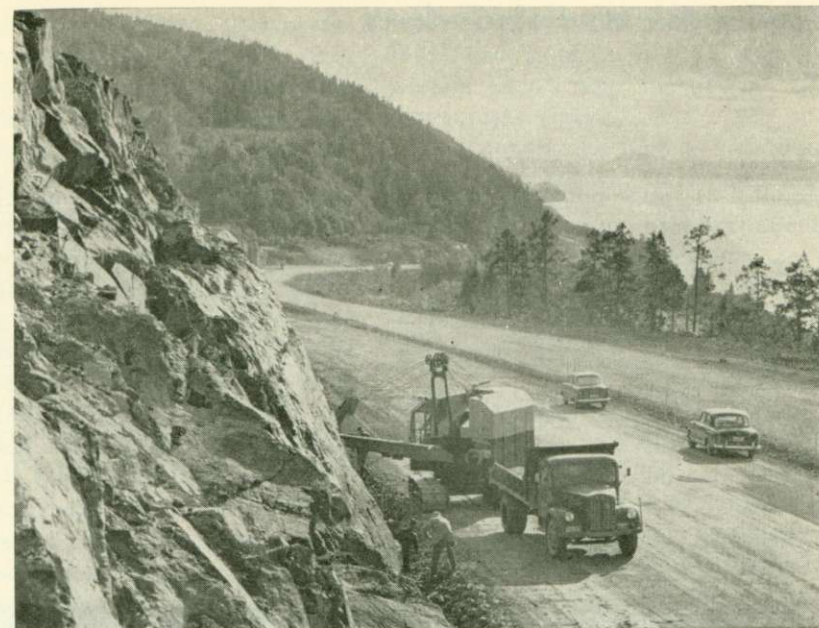
Motorvägen längs Vättern nära Huskvarna under byggnad.
