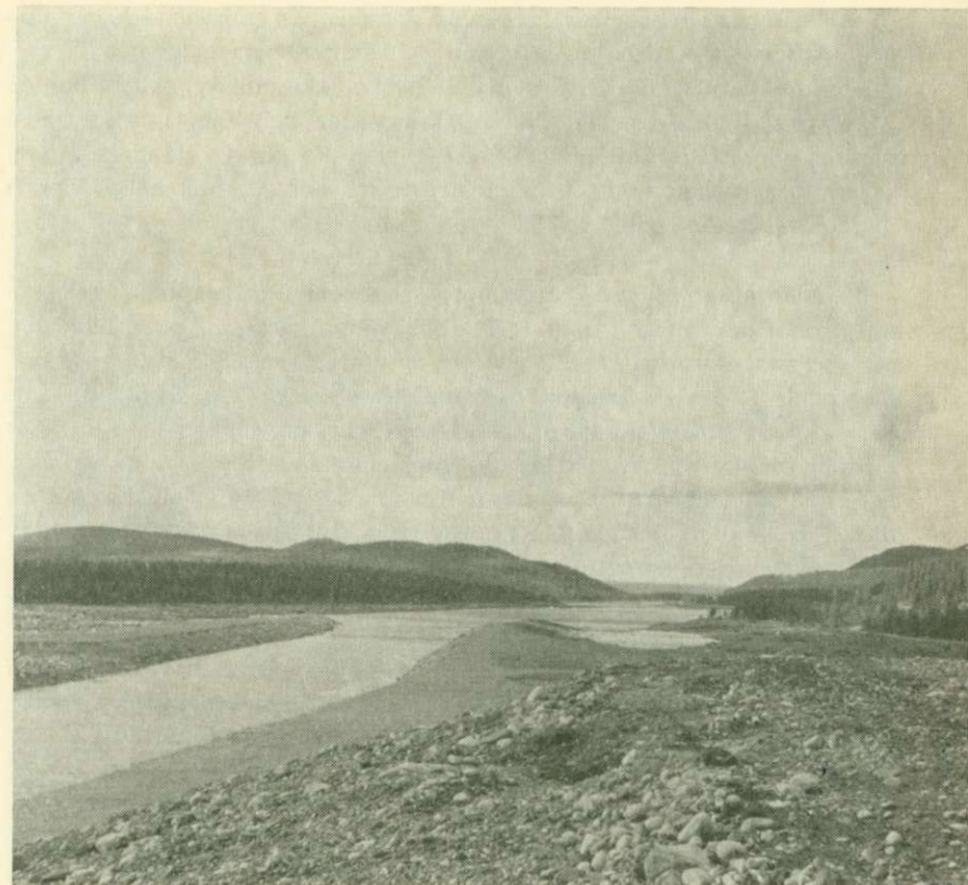
Sänkningskanalen vid Nysle, som skurits genom ett terrängavsnitt för att ge Stensele kraftverk största möjliga fallhöjd. Stora avsänkningar i mellanliggande älvmråde hör samman härmed. Bilden låter sambandet mellan älvdalens "skåra" i landskapet och sänkningskanalen bli åskådligt kännbart.
