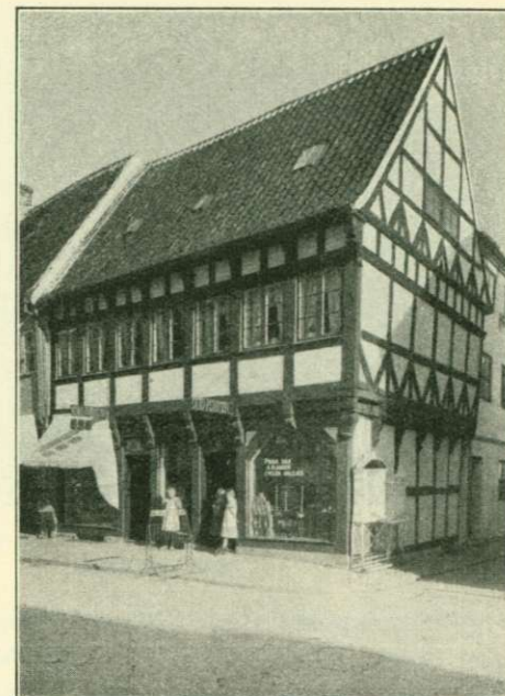
Stengade 20, Helsingør. Efter istandsättandet.
