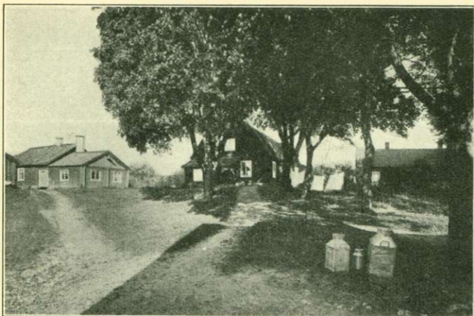
Grödinge prästgård, Södermanland. Sedd från uppfartsvägen till manbyggnaden. (Foto förf.)
