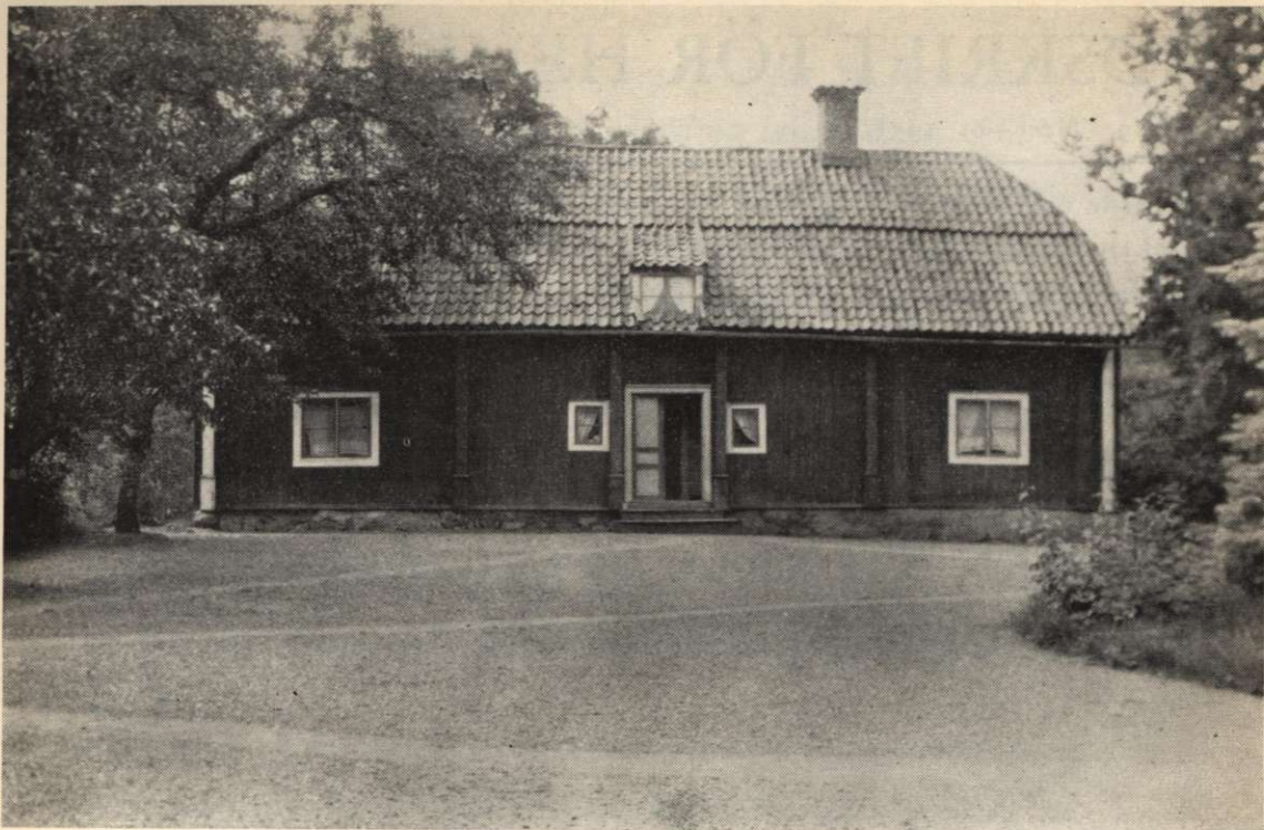
Flygelbyggnad vid S:t Annae kyrkoherdeboställe i Östergötland, ursprungligen prästgård, uppförd på 1600-talet och representativ för karolinskt byggnadsskick. Foto förf.
