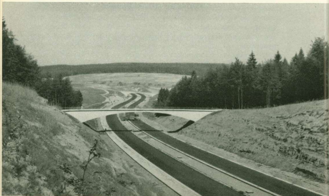
En av de eleganta betongbroarna inom Spessartavsnittet.
