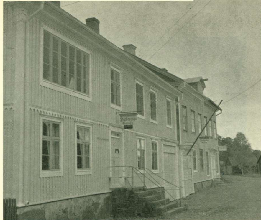
De två gårdar från 1800-talets början, som Ålems hembygdsförening räddat. I förgrunden Harbergsska gården och intill denna Hullgrenska gården. Båda gårdarna har bevarats som levande byggnader med samlingslokaler, museum o.s.v.
