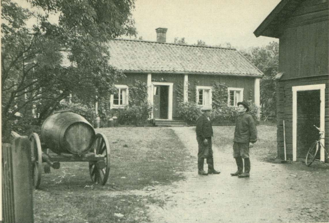
I de gamla byarna bestämdes byggnadernas mått av dimensionerna på det material man använde, med timmerstocken som största enhet. Ekeby by, Vänge, Uppland. — Svenska Dagbladet.
