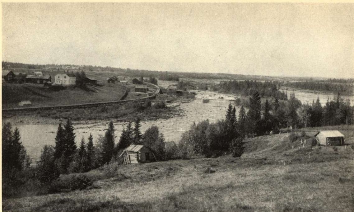
En 1902 tagen bild av Kengis Bruk från norra älvsstranden, visande på höjden bruksgården och ekonomibyggnaderna. Närmare älvfåran flottningsränna och uti älven dammanläggningar och de vid mittpunkten kvarstående verkstadsbyggnaderna.
