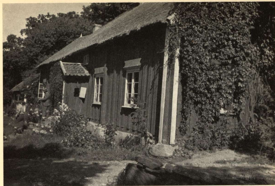
Ett stilfullt och välbyggt boställeshus från mitten av 1700-talet, Kullagård i Veddige socken, Halland.
