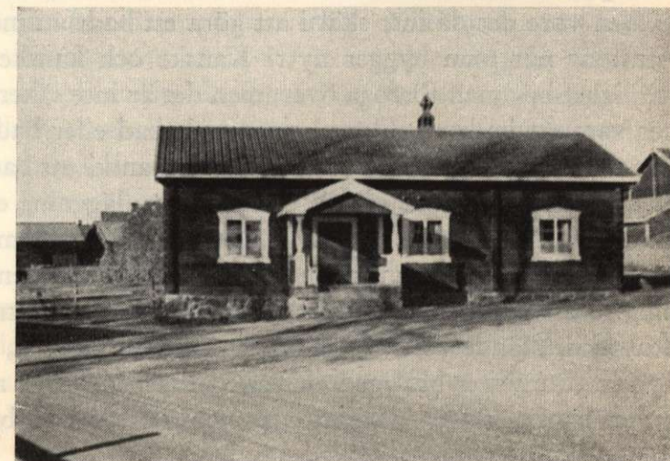
Bystugan i Färnäs, Mora socken. En byggnadstyp som här ännu användes och med fördel kan moderniseras.
