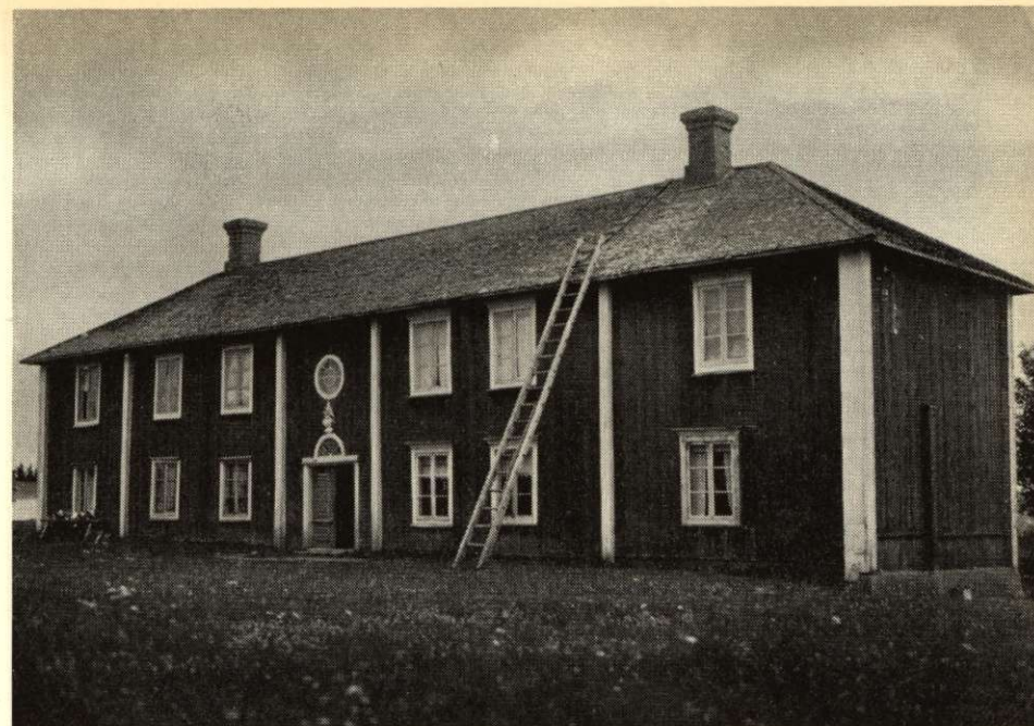
text: Grytan i Brunflo socken, Jämtland. Kronofogdeboställe från 1800-talets början. Exempel på träslott av ståndsmässig karaktär.
