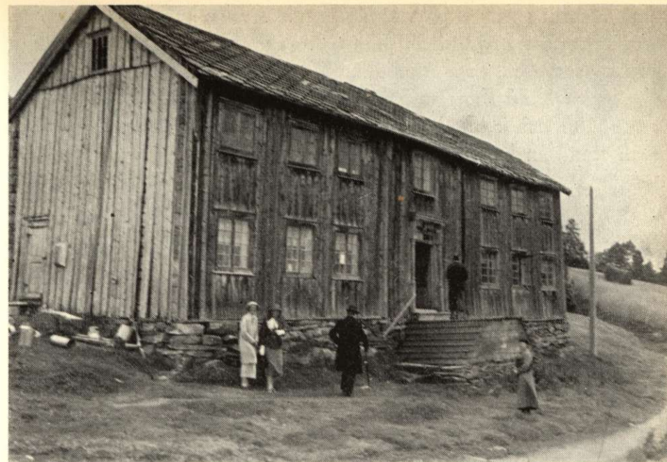
Gregersgården i Gäddede, Frostvikens socken, Jämtland, från 1700-talet. Gården är under restaurering och kommer att invigas sommaren 1936.
