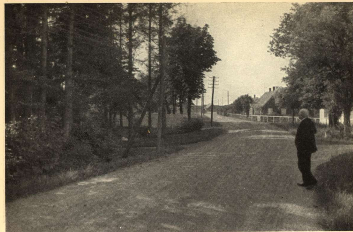
Den gamla vägen i Gråmanstorp. Genom en lätt rätning skulle man här slippa all vandalisering och likväl få en effektiv väg.
