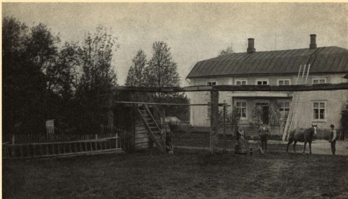
Kengis Bruk. Den märkliga, av trä byggda vattenledningen.
