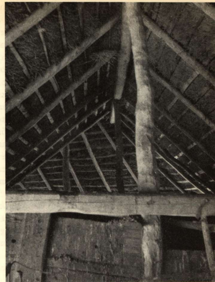
Mesulakonstruktion i ladugård, Akeraberg, Värö, Halland.
