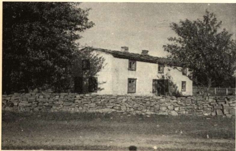
Flistakshus från Stenstu, Vamlingbo socken.
