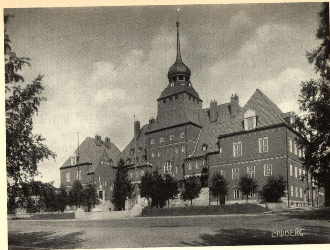
Östersunds rådhus, uppfört 1909—1912 efter ritningar av arkitekten F. B. Wallberg.
