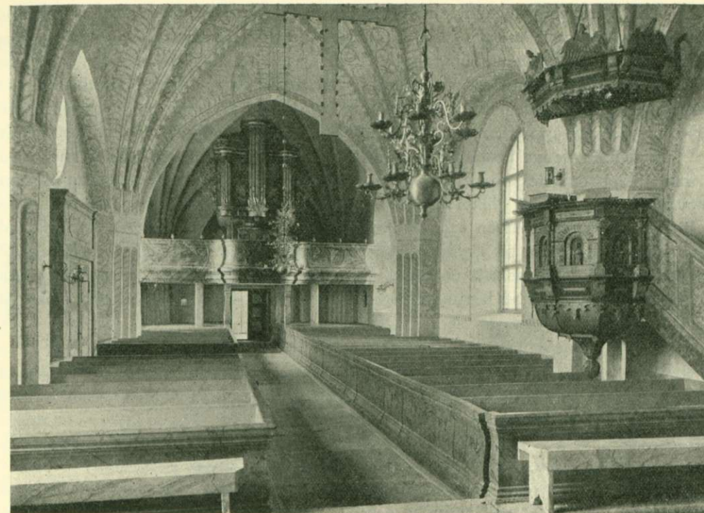
Det inre av Årsunda kyrka efter restaureringen. Mot väster.
