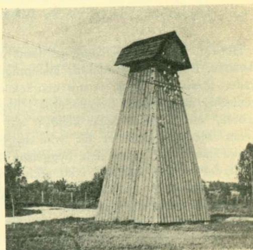
Transformatorstation vid Domnarfvet. St. Kopparbergs Bergsl. A.-B.
