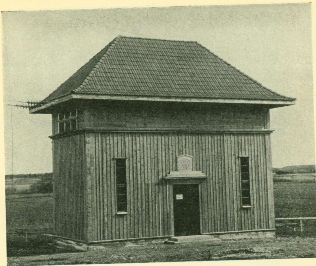
Kopplingsstation vid Ekesund. Kungl. Vattenfallsstyrelsen.
