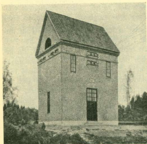
Transformatorstation vid Älvkarleö. Kungl. Vattenfallsstyrelsen.
