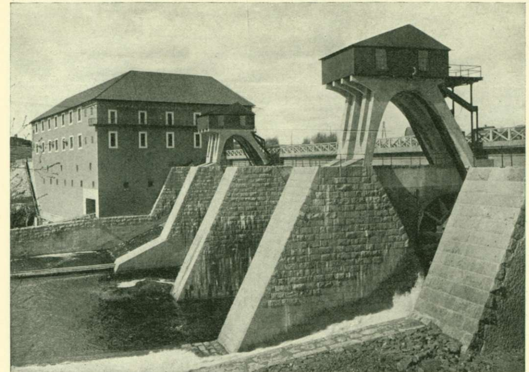
Forshuvudforsens kraftverk i Dalälven.
