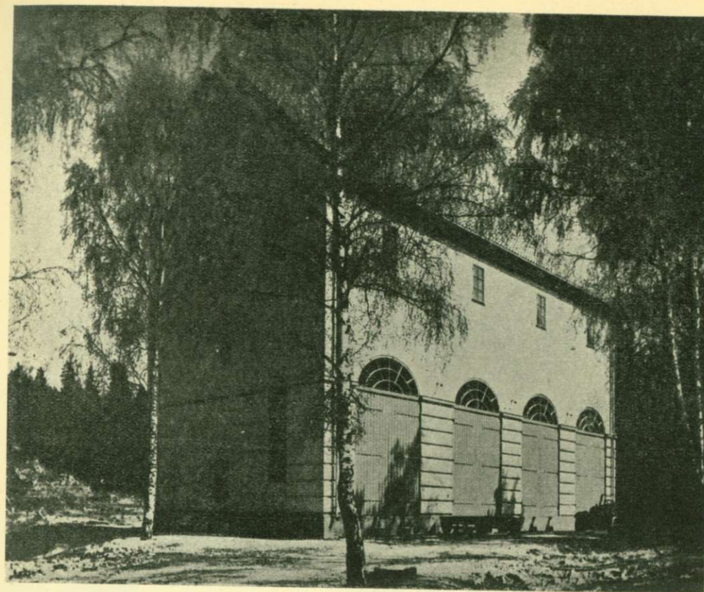
Sekundärstation vid Norrviken. Kungl. Vattenfallsstyrelsen.
