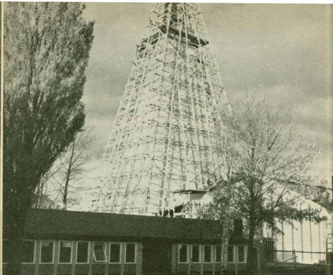
Katolska kyrkan under byggnad.
