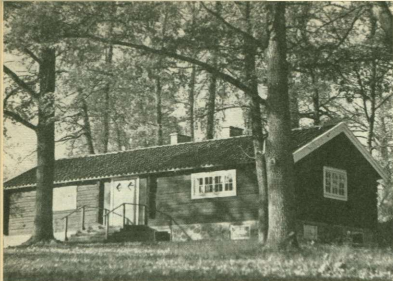
Hyltinge hembygdsgård, den s. k. Byringe-stugan, Sparreholm, som är flyttad och ombyggd till modern samlingslokal.
