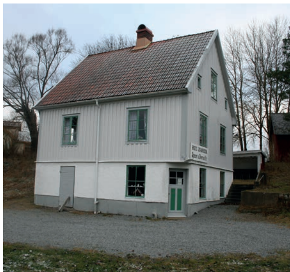
Fönster och träfasader på lanthandelsbyggnaden har målats om med linoljefärg av Vrigstad Byggnadsmåleri AB. Foto: Olle Mill
