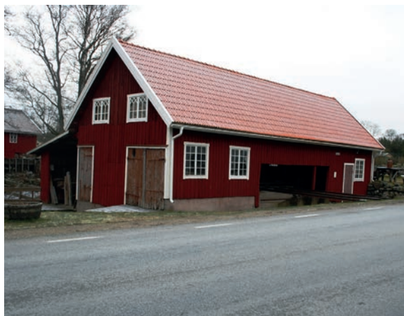
Cirkelsågsbyggnaden efter takbytet 2018. Foto: Olle Mill
