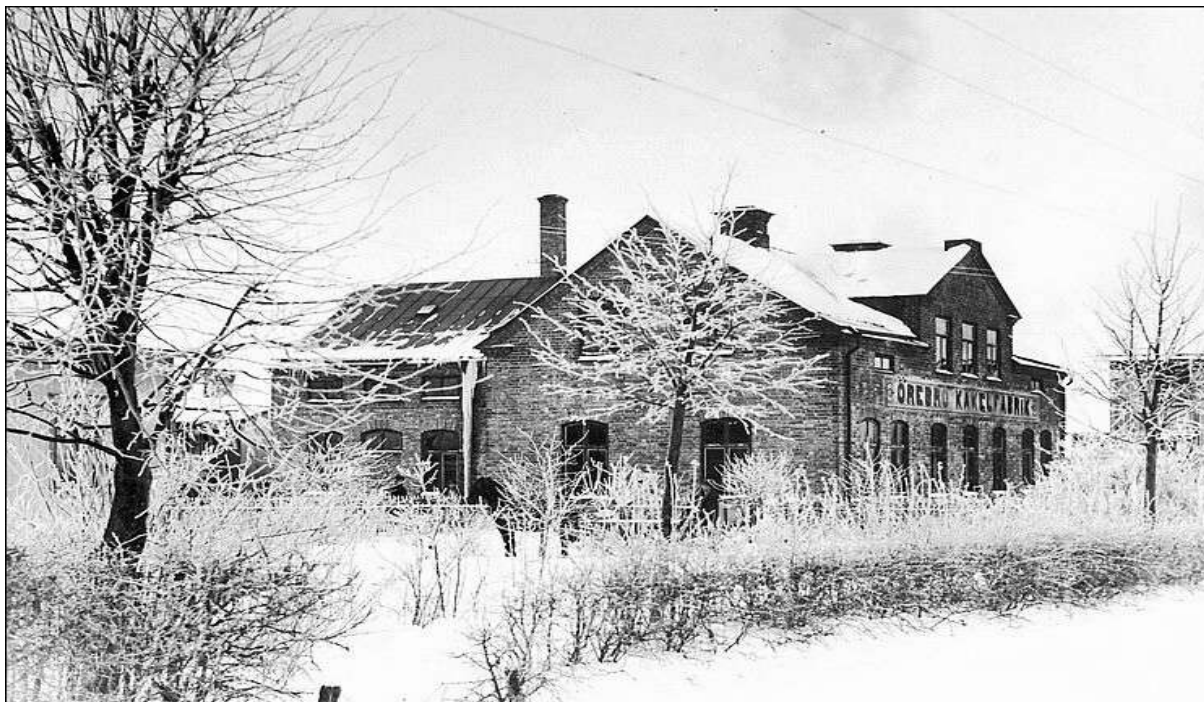
Örebro Kakelfabrik på fastigheten "Rörstrand" Bildkälla: Sällskapet gamla Örebro Foto: Axel Barr
