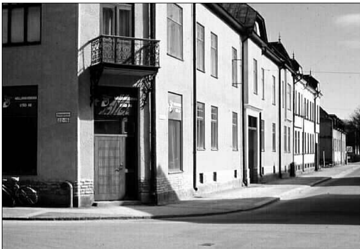
Martin I Andersson flyttade verksamheten till hörnet Fredsgatan 29. Huset som skymtar längst ner i bild är f.d. Östberg'ska Kakelfabriken.
