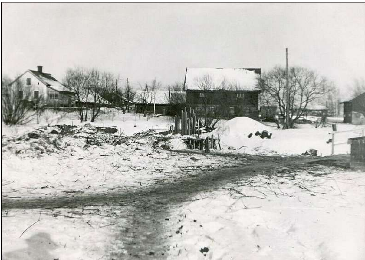
Bostadshus och övriga byggnader vid Tegelbruket
