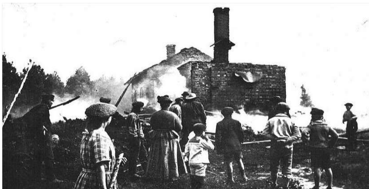
Branden vid Backa Stenkärlsfabrik 1921
