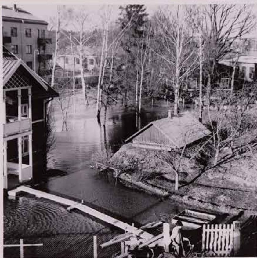
LILLSJÖBACKENS ÖVERSVÄMMNING VID VÄRFLÖDET 1951. Vid bron över Kalkugnsvägen hade kulverterats i Nov.1950. Till h.del av Järnvägsverkstäderna. Till v.upp del av "Näcken" byggt 1948. Närmast till v.Kvarteret Järnvägen N:o 4, Kalkugnsvägen 15; Järnvägens eget nummer 9. Innehöll lägenheter för 4 familjer till Järnvägsanställda. På 1930-tal bodde: Stationskarl O.J.Cederberg infl.från Kullerstad 1926. Verkstadsarb.Johan Alfred: Eriksson f.12.3.1880 i Torstorps Norrgård (med Föräldr.i Mellangrind 1882-1904)infl.vid Gi.1922 med Antonia Viktoria f.22.9.1886 i Axsäter. Verkstadsarb.Johan Fredrik Liljeqvist f.17.3.1879 (Fadr.Wagnmakare Anders L.i F-ng)infl.från Linköping 1911. Förrådsförman Emanuel Rosén f.1888 i Ö.Harg, infl.vid Gi.1913; byggde i slutet på 1940-talet Sundsvägen 37. Till Alkistan 3 kom från Väderstad 1930 Verkstadsarb.Algot Johansson och hans fru Lilly, infl.hit efter Rosén; Algot D.6.5.1974. Foto ovan Stig Skoglund(bor på Höglint) nedan egna foton med laddkamera.
