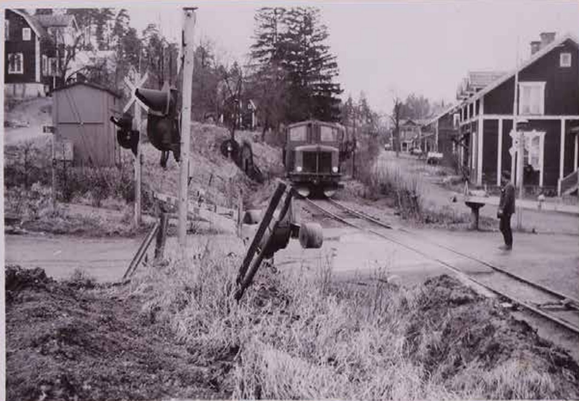
Foto Sture Kullander Torstorp. Järnvägsbostäderna revs enl. uppgift 1977. Längst till v. Holmsbacka byggt 1912, sedan Berggrens Elinsberg 1917 och Envalla. Lilla byggnaden vid bommen var eltransformatoranläggning. Nedanför där fanns en vaktkur för personalen till bomarna och i kuren reglage för växel och signaler. Togs troligen bort med persontrafikens nedläggning år 1962. Canch 26.2.14
