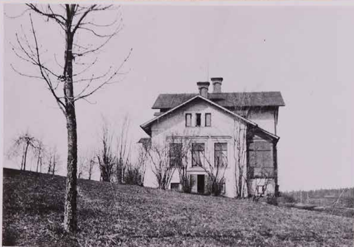
"MAJORSVILLAN" började byggas 1875 efter ritningar av Axel Kumlien, och uppfört för den förste Trafikchefen på den 1874 öppnade järnvägsdelen Pålshoda-Finspong som var Sven Oscar Kamph f. 1837 i Karlstad och som hitkom 1874 från Boo och kvarstod i sin befattning tills han gick i pension år 1902. Efterträdaren var dåvarande Kaptenen senare Major vid Kungl.Väg- och Vattenbyggnadsstyrelsen Erik Malkolm Lindgren f.1867 i Stockholm, som hitkom från Halmstad 1902. Han blev sedermera Verkställande Direktör i Järnvägsbolaget från den 1.11.1909. Han avled 20.3.1940. Huset tillbyggdes 1917-18 med gavelbyggnaden mot Vallonvägen. Stod obebodd från 1941 tills December 1947 då det inreddes till Kommunens Byggnads- och Arkitektkontor. Numera använt till Musikskolans lokaler. Foto från 1890-talet. O.B.S. den kala terrängen.
