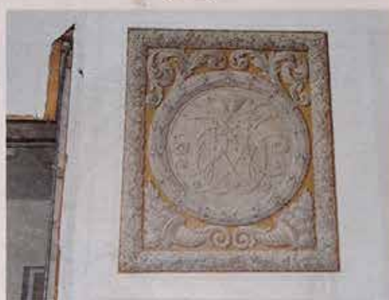
SKA SPARAS. Ett stiligt ornament inne i Majorsvillan plockades bort före torsdagens rivning och är nu räddat för eftervärlden.
