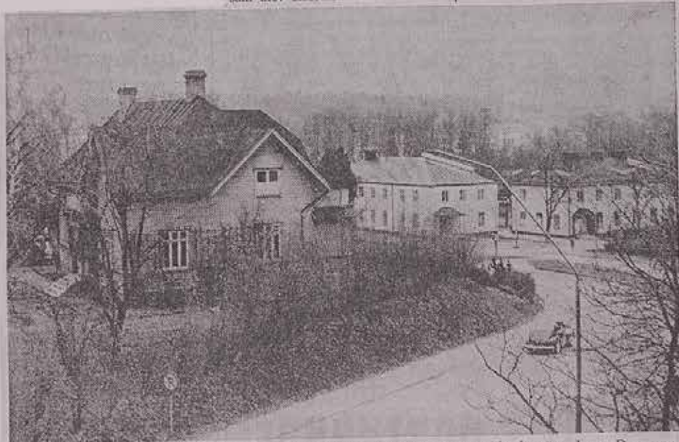
Den kända Almqvistiska villan i Finspångs centrum skattar i dagarna åt förgångelsen. Den uppfördes 1906 av distriktsveterinär Karl Almqvist och inrymde också på sin tid Östgötabankens kontor.
