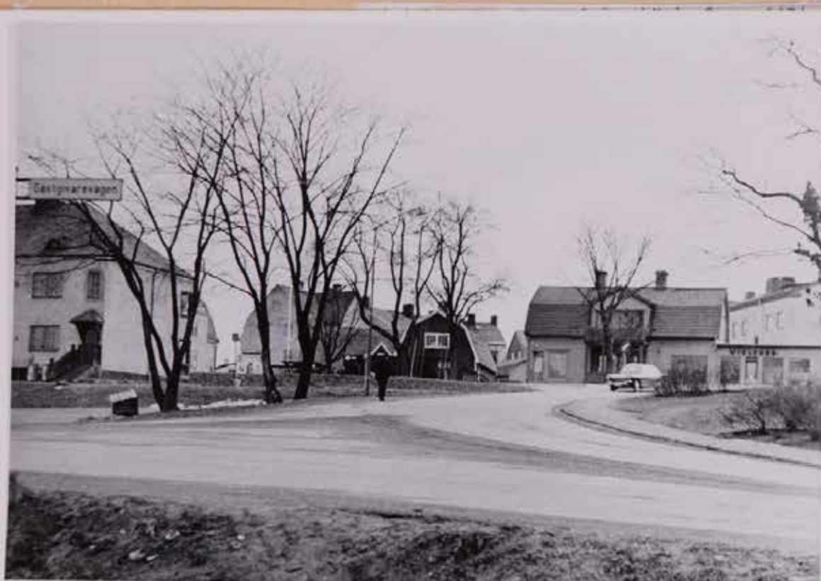
KORSNINGEN GÄSTGIVAREVÄGEN/VÄRDHUSVÄGEN upp mot Vallonvägen. Till v.F-ngs 1:a Radhus byggt 1917, rivet Mars 1971 för Hotell de Geers utbyggnad; Jernbolagets byggnader revs 1975, samt f.d.Edqvistska Gården. Wiklunds kappaffär flyttade till centrum 1972, före Wiklund var här Engbergs Elektriska Affär. Till v.ingången till F-ngs Blomsteraffär. Edqvistshuset revs 1973. Samma vy foto Ännen sidan 150.
