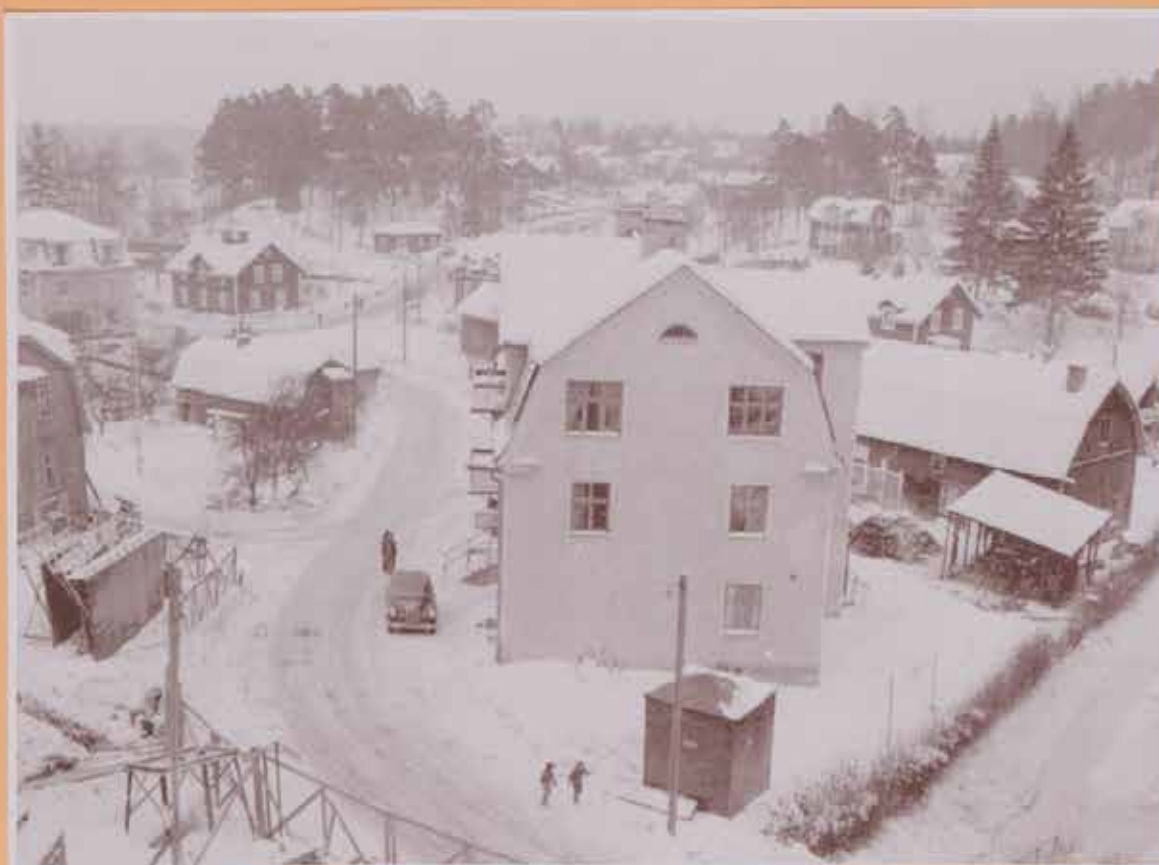
DE WIJKS VÄG sett åt öster. Närmast Karlsdal byggt 1922 rivet våren 1963 för ny bebyggelse. Emot till vänster skimtar Villa Borg med uthus nere i svängen. Upp till vänster Nya Hotellet, Järnvägsbostället, lilla mörka huset Lindsboms Mjölksaffär började rivas 22.4.1983 (se nästa sida) uppe i tallbacken var deras bostadshus. Till höger om dungen huset där jag var uppväxt (se sidan 102) Se även Foto Årnen Flygfoto sidan 10 - 11. Canonkopior 20.8.2014.
