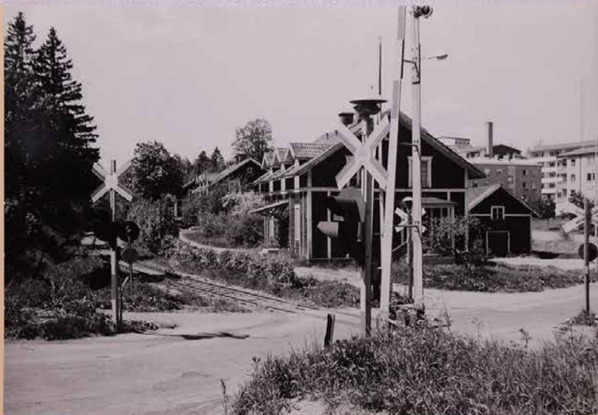
JÄRNVÄGSÖVERGÅNGEN MOT HÖGKLINT med husen JÄRNVÄGEN 6-12 var 4 stora röda hus för Järnvägsanställda fanns i Oktober 1967 men då i mycket dåligt skick; var här då planerat för ny väggenomfart. Hyreshusen i bakgrunden på De Wijks väg färdiga i etapper 1963-64. Sista personförande tåg gick här den 1.7.1962, D:o godsförande tåg 1.7.1987, rälsen uppbruten i December 1990. Foto Stig Skoglund.
