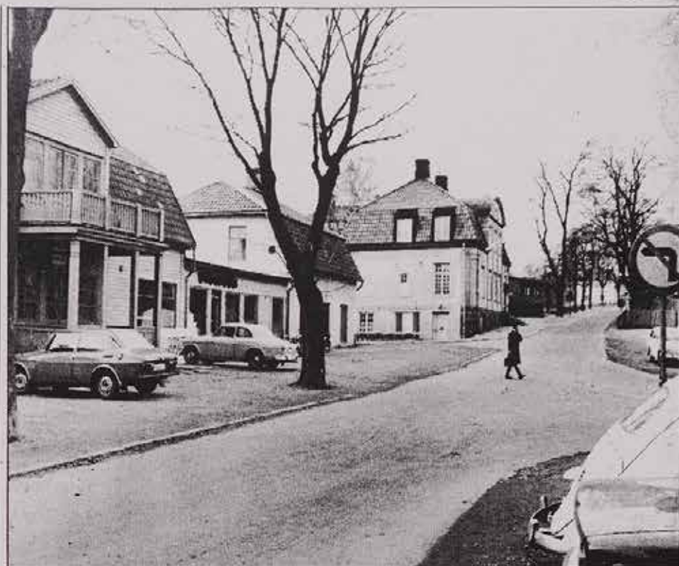
Det blir en hel del förändringar av gatorna i anslutning till det nya hotellbygget i Finspång. Byggnaden t.v. skall rivas och Jonas Wenströms väg mellan rivningshuset och gamla kommunalkontoret breddas och får en delvis ändrad korriktning. Vårdshusvägen där damen på bilden går läggs igen och ersätts med en förlängning av Jonas Wenströms Väg.
