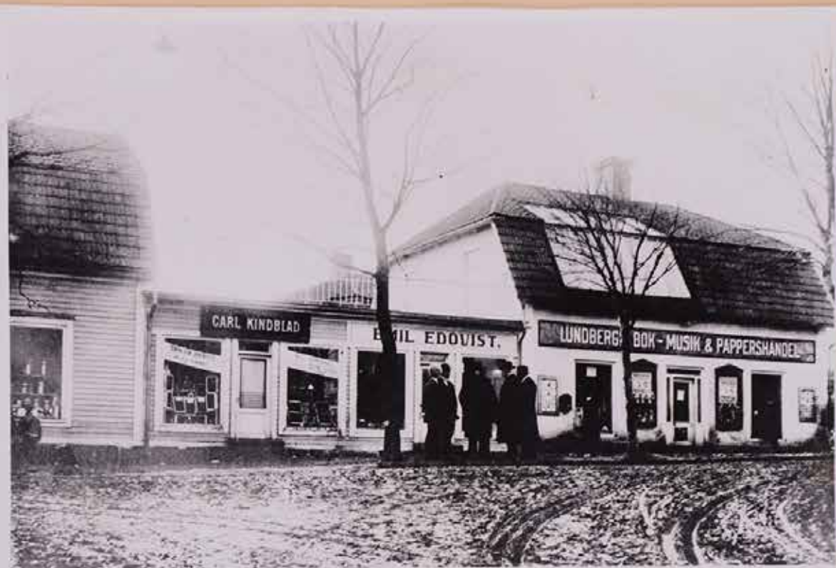
FINSPONGS 1:a AFFÄRSHUS "EDQVISTS GÅRD" i Kvarteret Högbyskolan N:o 16, senare ändrat till Köpmannen N:o 5, Vallonvägen 17. Se spårig väg och fönstren mot norr till fotoateljén. Foto mellan 1917-1923. Se i övrigt Bilaga text.
