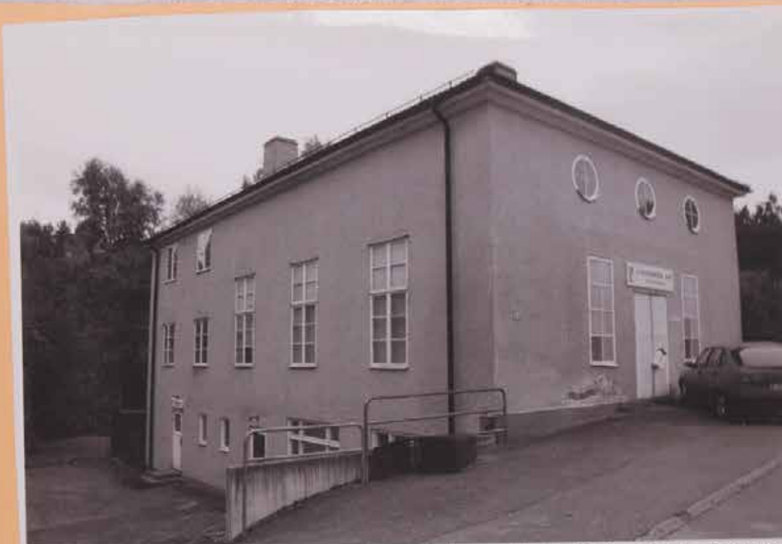
BETANIA el. FILADELFIA Pingstkyrkans lokal Alkistan 10, De Wijks väg 7. Lokalen invigd 8.12.1932; Pingstkyrkan i F-ng bildades 1927. Ritningarna gjordes av Byggmästaren Sven Rikard Narbrink i Butbro, byggkostnaden var 30,000:- plus tusentals timmar av medlemmarnas eget arbete. Vid De Beschevägen byggdes ny kyrkobyggnad färdig i Febr.1962, FAIK bordtennis övertog då den gamla lokalen. Kommunen köpte marken 1960 för en då planerad ny trafikled. Revs årsskiftet 2016/17 mycket snabbt rivet bortforslat och marken utjämnad, inte ett ord i ortspressen. Canonkopia 17.9.2016.
