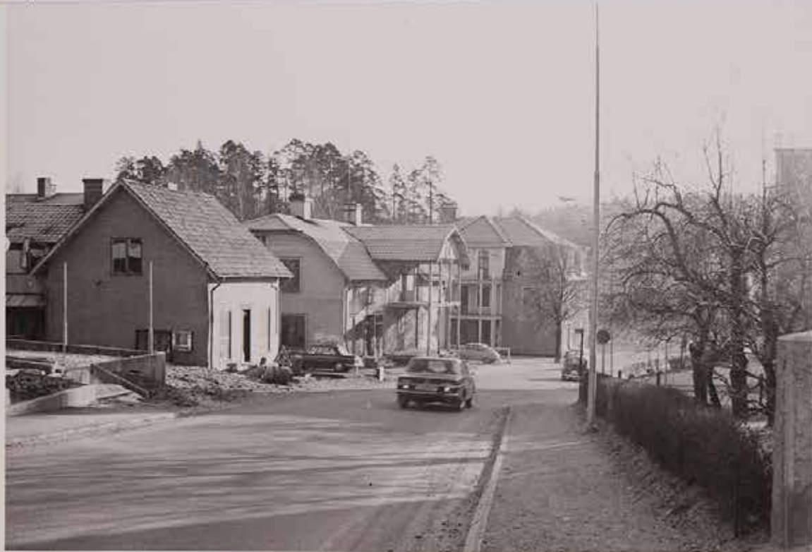
KALKUGNSBACKENS NEDRE DEL. Längst ned Nya Hotellet byggt 1918 rivet i Mars 1971. Där hade Kommunen en del av sina förvaltningslokaler medan nya Förvaltningshuset var under byggnad. Uthuset bakom Hotellet utrivna våren 1967. Hotellet upphörde sin verksamhet i Juni 1967, området inköps av Kommunen 1962. Huset i Mitten Villa Mariedal byggt 1908 rivet 1967. Sedan handlare Karl Levin Alms 1:a affär "Röda Stugan" hitkom i Maj 1910. Kom till F-ng 1898 som Kusk hos Ekman. Avled 28.8.1934, hade överlåtit affären på sönerna Sven och Brik år 1932, som lät bygga ny affär och bostad 1936 med David Bengtsson som byggmästare. Drevs av bröderna till Nov.1948 då den inköptes av Eric Svensson som drev den till 1.7.1967 varefter huset nedrevs på en dag tisdag 25.7.1967. (synes rivningsplatsen längst till v.) "Röda Stugan" var en tid utminuteringsställe för Systembolaget och sista tiden kontor för nya Förvaltningshusbygget, revs i Febr. 1971. Längre upp(ej på bild) byggde Slaktare Arwidsson sin affär och bostad färdigt i Nov.1910, nedrivet i Okt.1965. Se även Bilaga David Eriksson. Foto Stig Skoglund.
