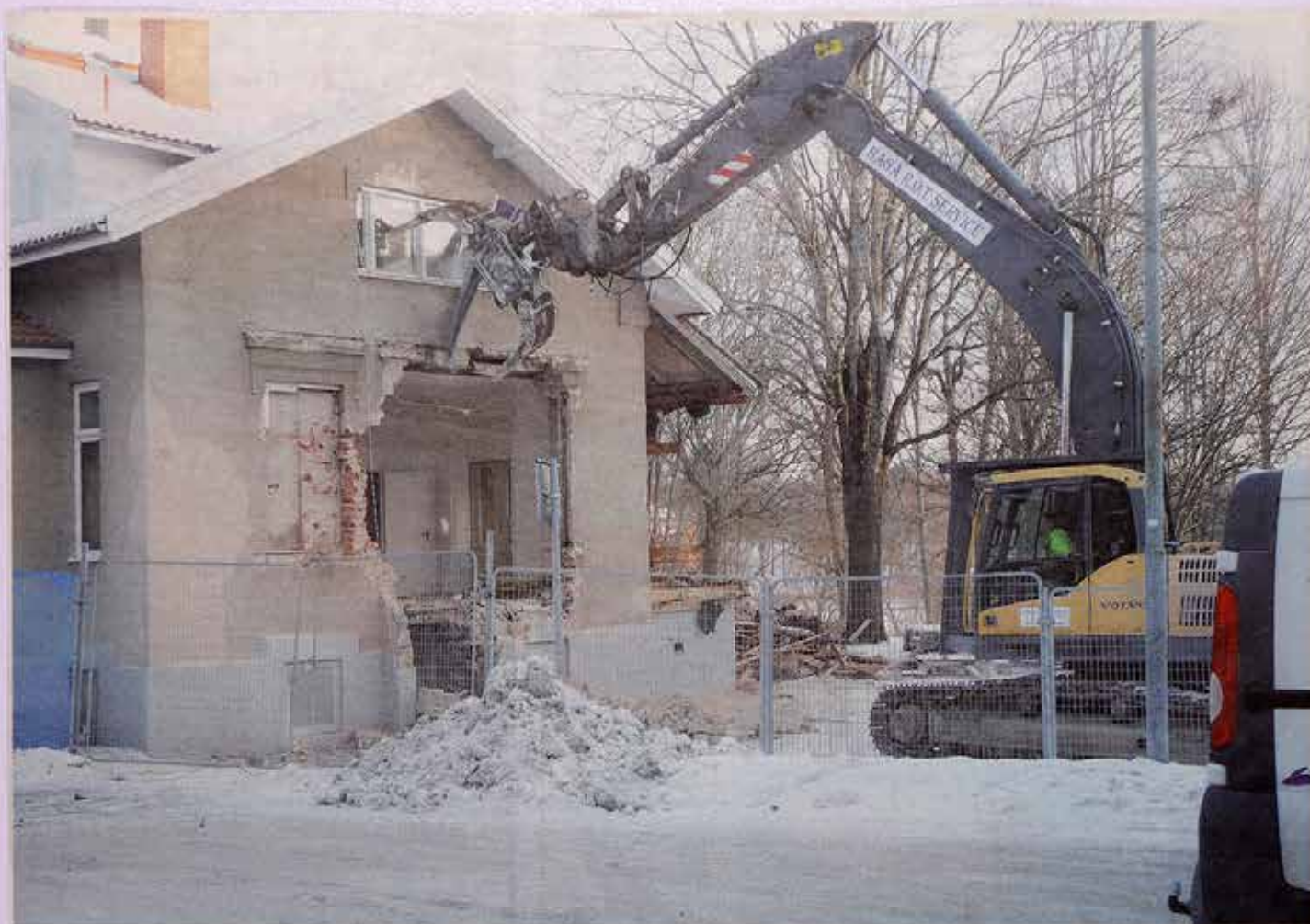
SLUTET. På torsdagen satte grävmaskinen i gång att riva Majorsvillan i centrala Finspång där ett åttavåningshus nu ska byggas av Vallonbygden.
