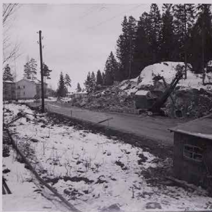
INFARTEN FRÅN ÖREBRO MOT FINSPONG vägen breddas och ombyggs. I mitten skimtar Lamell-husen. Eget foto 1956.
