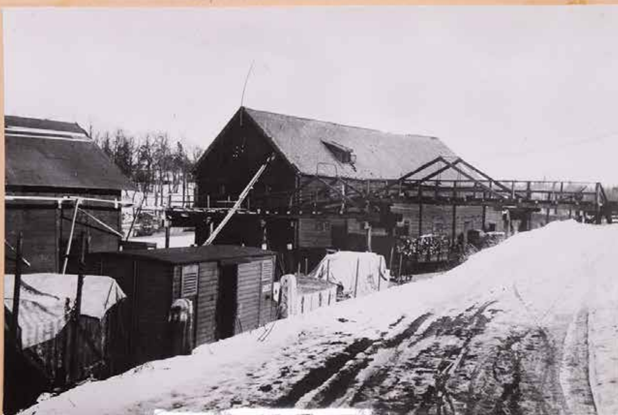
JÄRN OCH SPANNMÅLSMAGASINEN straxt norr om Spettaln. Till h.övre bild tillhörigt Hellestad, till v.och nedre bild Finspongs Bruks Järnmagasin byggt 1793, rivet i slutet på April 1950. O.B.S. att den ljusa byggnaden på gaveln även synes på bild sidan 61 ned. Här var även ändstation för Lotorpsbanan.
