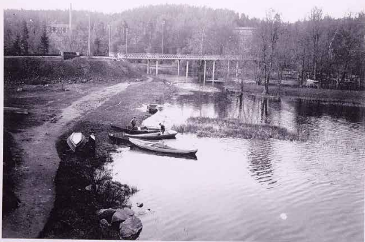
DEL AV SKUTEN OCH GAMLA JÄRNVÄGSBRON, till v.i bakgrunden synes Butgården, till h.ett Uppsättningshus. Foto C:a 1920 synes pågå utfyllnad för vägbank till vänster=nya bron. Se omstående sida samt Foto Ämnen sid.89. Anjotr.kopia 19.1.-04.
