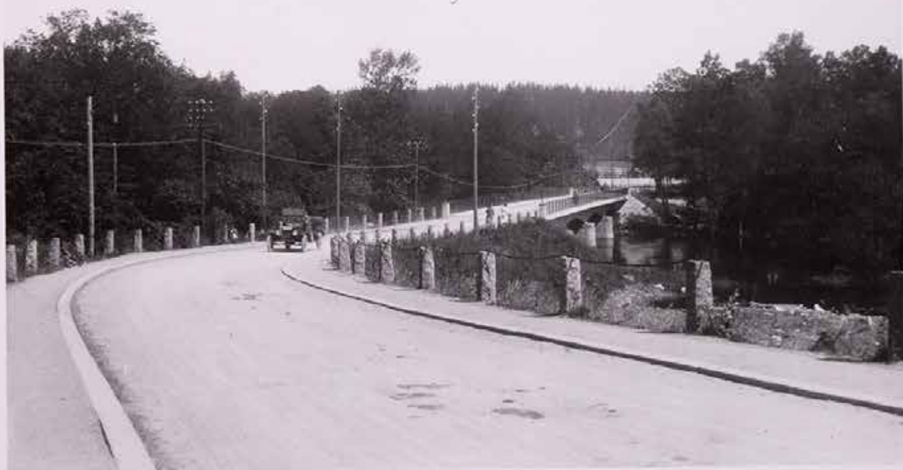
"NYA BRON" påtänkt redan 1906, slutgiltiga förslaget fastställt 10.12.1920. 16.3. 1921 skrevs kontrakt med A.B.Arnerad Betong Malmö; kostnaden blev 348,000:- Bron avsynad och godkänd 8.11.1922. Tidigare var enda vägförbindelse genom Finspong över Bruksområdet och Hällestadsbron. Upphörde som broförbindelse den 2.11.1967 då nya bron öppnades. Revs våren 1970. Foto år 1924. (även ned)
