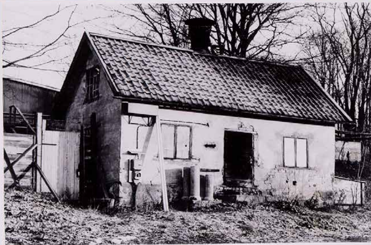
SELKAMMAREN TILLHÖRANDE FINSPONGS LANTBRUK. Var belägen bakom Stallet; läge se Ännen Flygfoto sidan 3, 4 samt 8. Nedrevs år 1970.
