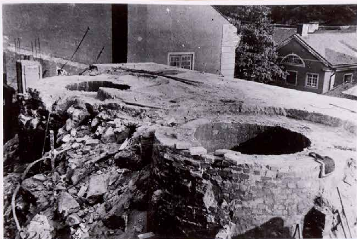
Masugnen rives sommaren 1913. Till höger synes tråddrageriet. Masugnen uppbyggd 1820-26 till en kostnad av 84507 Rdr 32 sk 9 rst rgs, och byggd med 2 pipor, var en av Sveriges förnämsta masugnar.
