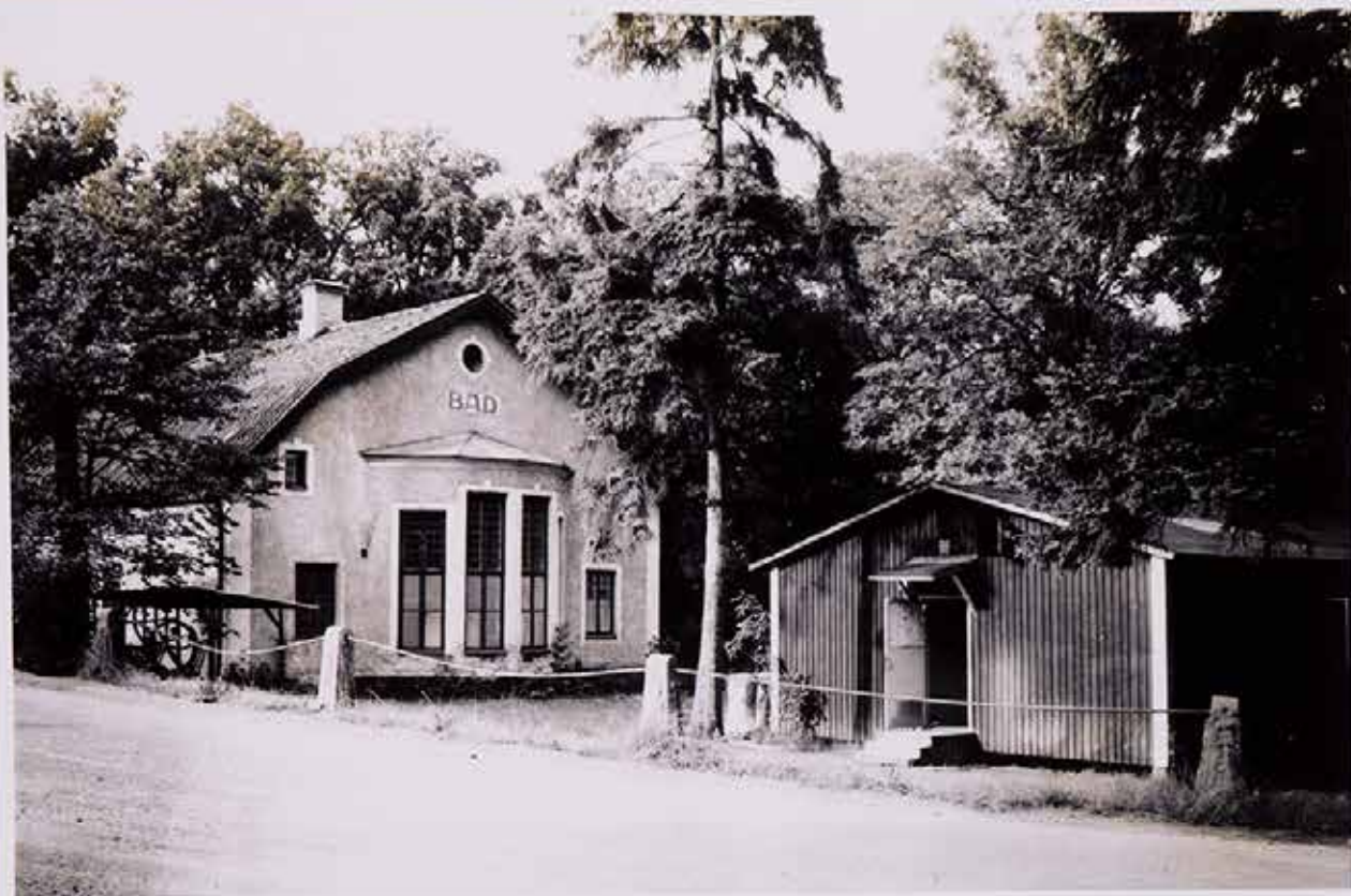
FINSPONGS BADHUS byggt 1907, stängdes 28.1.1967. Revs, slogs ned med grävskopa den 26.10.1967. Nya simhallen öppnades 6.2.1967. Till h.Metallens Ungkarlsbarack.
