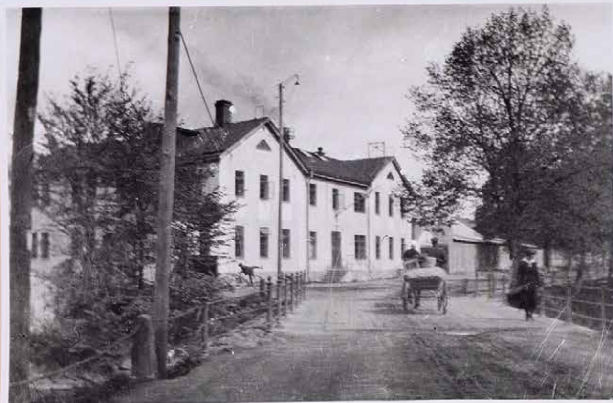
Kanalbron med gamla kontorsbyggningen.
