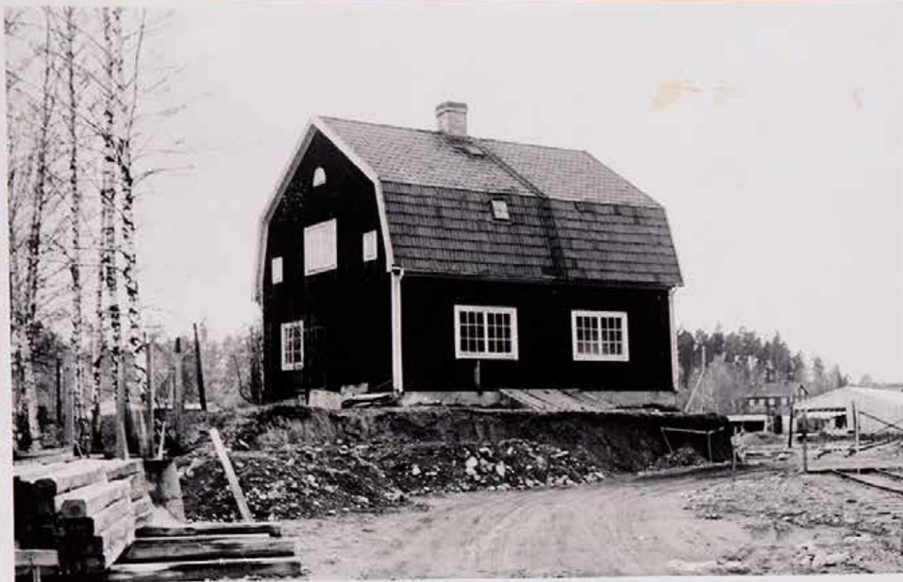
ÖVERMONTÖR FREDRIKSSONS VILLA vid Myrkärret, byggt efter 1918. Infl.från Grängesberg 1908 som Montör Johan August Fredriksson f.1882 i Norrbärke; Gi.s.å.med Edla Vilhelmina f.1884 i Nås. Hitkom från Grängesberg 1918 Svåger Montör Harald Emanuel Falk f.1891 i Hällefors, Gi.7.9.1919 med Tekla Evelina f.1890 i Norrbärke; de bodde i övervåning. (Montör Fredriksson se Foto F-ng Pers.sid.65 upp) Två tjänstemannabostäder byggda efter samma ritning (bara de två) denna och "Vallonvillan" Vallonvägen 20. Hade adress Norra Gatan 14, i Kvarteret Kusken N:o 8; egendomligt eftersom läget är långt från N.Gatan. Längst bort till h.Brunnshuset, samt kalllager för Metallen. Foto öde 1957.
