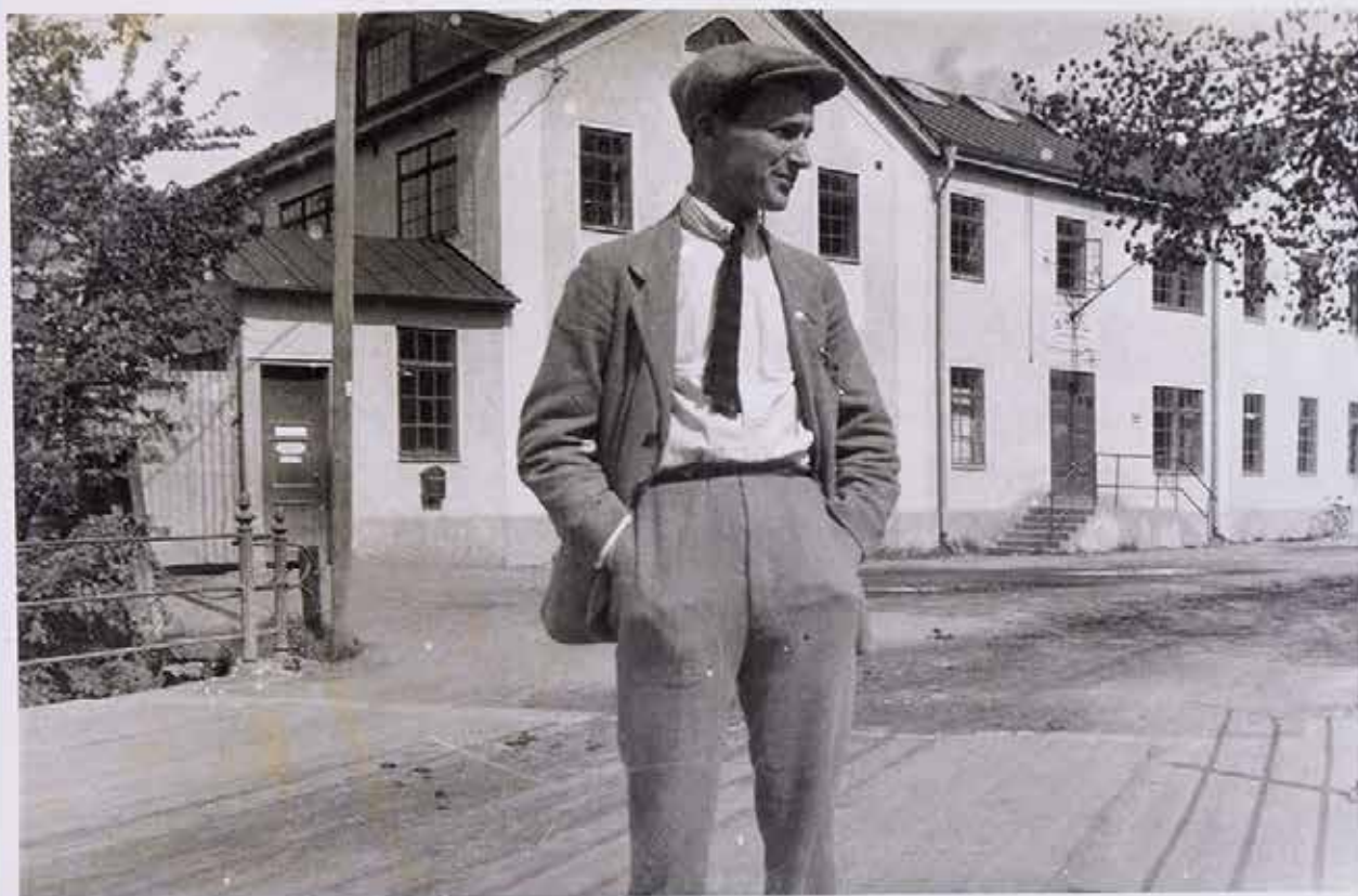
STAL:s GAMLA KONTORSBYGGNING med verkstadsportingången åt vänster, och konkorsingången åt höger. Ursprungligen byggt 1903 av då nybildade AB Nordiska Artilleri- verkstäderna, tillbyggdes och utvidgades efter STAL:s etablering 1913. Revs för De Geersverkstadens nybyggnad i januari 1944. Mannen är HARRY EK f.22.12.1900, avled 10 januari 1929 i lungsot. Foto C:a 1925.
