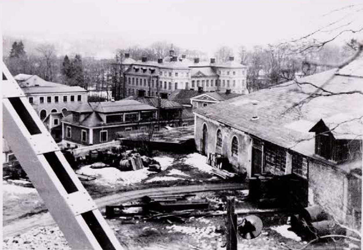
NYBYGGNAD INOM METALLENS OMRÅDE 1946. Balken tillhör stomme till nya Valsverket. Till h.g:a Kolhuset; gjorts Murbruk. Där startade 1931-32 på experimentstadiet den första gjutningen av aluminium i Finspong. Revs Januari 1954 för att ge plats åt nya Aluminiumgjuteriet. I mitten Slottet, Kontoret "1705" och Kvarnen; var Laboratorium 1930-63. (G:a Kolhuset se även Foto Ämnen Flygbild sid.4, 5 och 7)
