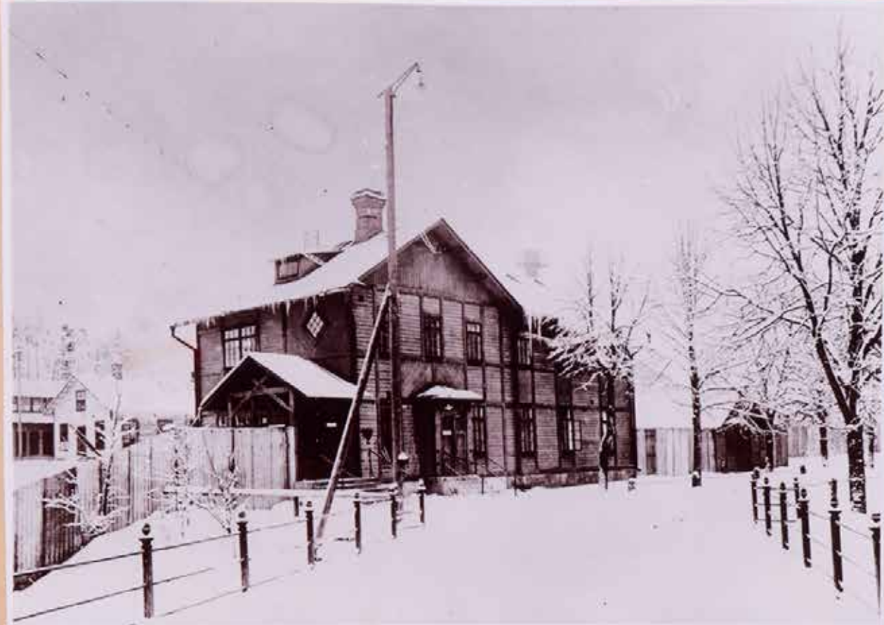
KONTORSHUSET foto före 1913. Fönstren ovan Verkstadsingången tillhörde Portvaktsbostaden. Där bodde Moa Martinsson som barn med sin Moder och Styvfader som arbetat på Kanalbygget och blev därefter Portvakt, Modern skötte telefonväxeln och hade hand om städningen av Kontorslokalerna. Kom från Fridenlund Gullerstorp Nov.1903: Portvakt Karl Alfred Karlsson f.1872 i Norrköping, Gi.11.3.1896 med Kristina Swartz f.1871 i Vårdsnäs; he:s dot Helga Maria (Moa) f.2.11.1890 i Vårdsnäs. Moa utfl.till Kuddby 1905 och Moder och Styvfader till Ö.Eneby Oktober 1906.
