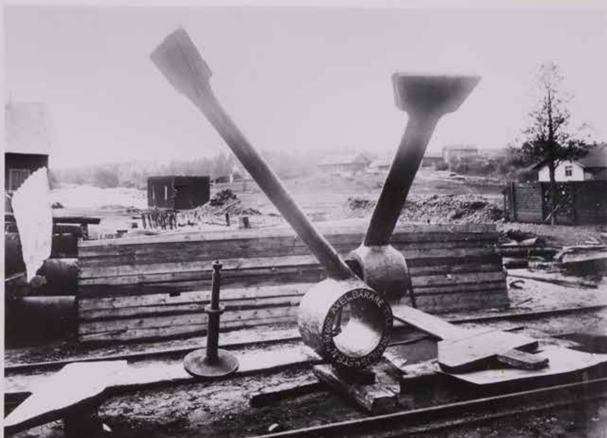
Maskindelar till pansarbåten "Manligheten" tillverkade vid Lotorps Bruk. Övre bild märkt: "axelbärare till Manligheten vikt 1,900 kg". Nedre bild taget utanför gjuteriet fartygspropeller till Manligheten, märkt "12 fot" (=3,56 meter) Manligheten började byggas 1901, och sjösattes 1903. Var 15 meter bred och 89,7 meter lång, var i bruk till år 1950 då betydligt omändrad och moderniserad. Se även sid.6 upp.
