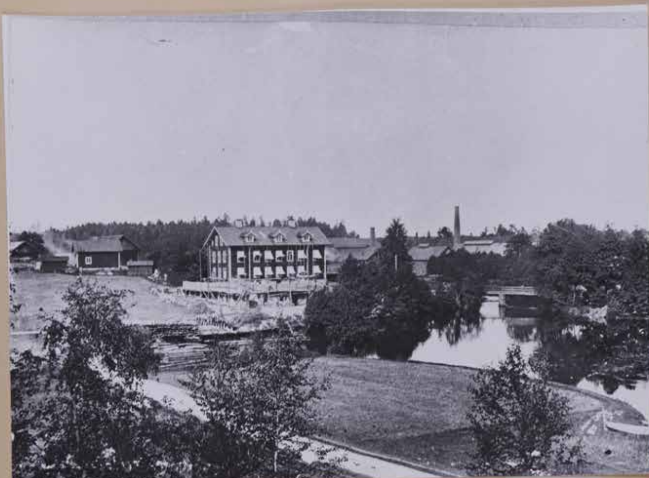
FÖRSTA HUVUDBYGGNADEN från 1884 -gamla tryckeriet- samt nya fabriken under byggnad. Delar av Bruket till h. Foto från Strömsborg 1897.
