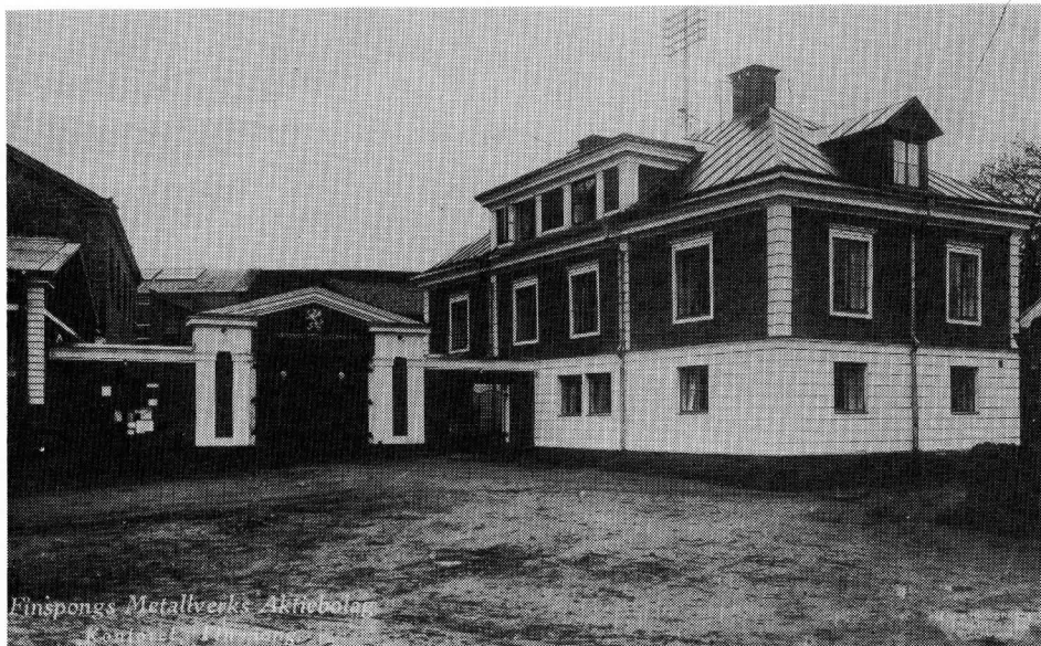
Bild 5. Metallverkens kontor 1930. Byggnadens nuvarande utseende.
