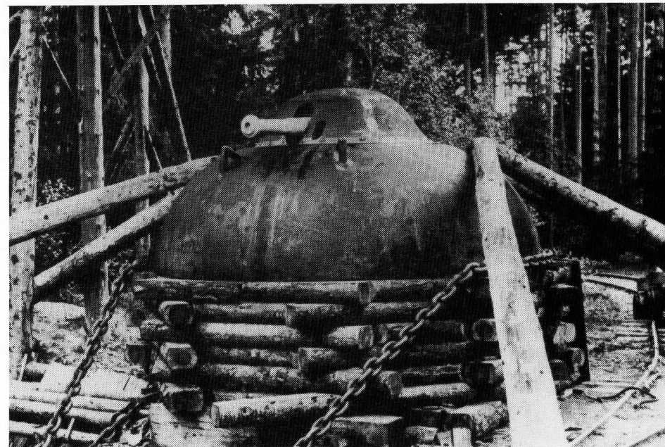
Pansartorn under provskjutning. Provsköts första gången i mars 1891. Här syns tydligt kättingarna till den nedgrävda kanonförankringen, samt spåren från verkstäderna till höger.
