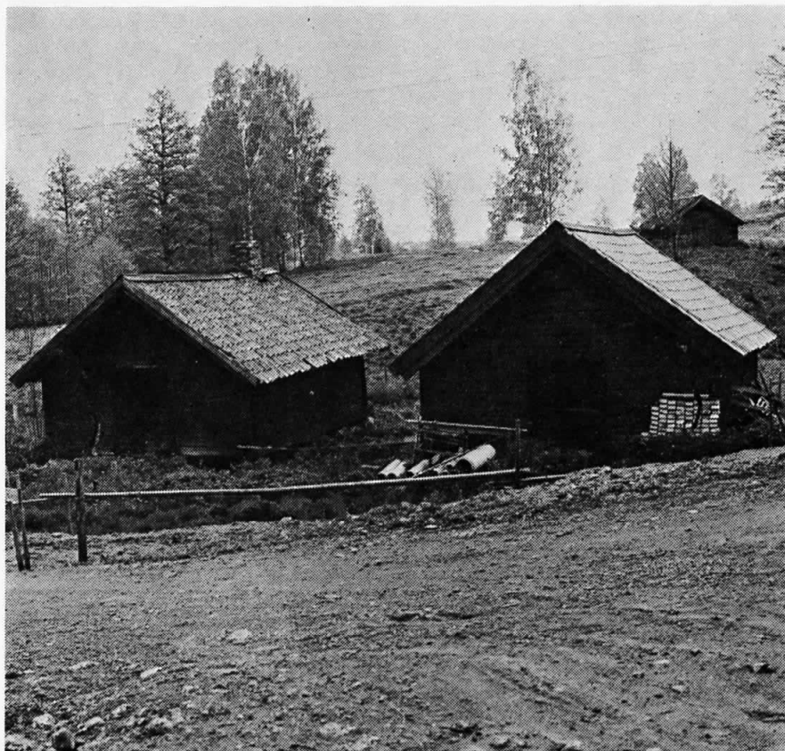
Lämmetorp. — Tvättstuga och bryggbus
