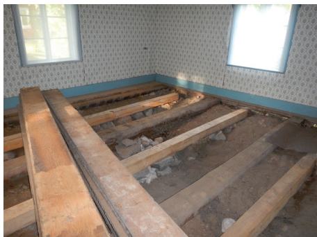
Golvplankor återanvänds men extra bjälkar läggs in
