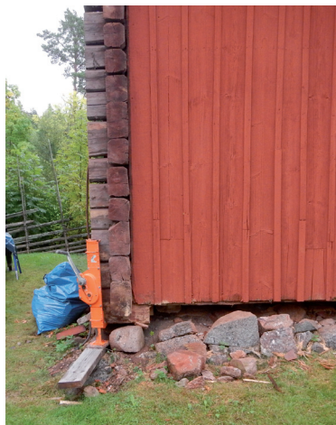
Lyft av husknut och byte av syll
