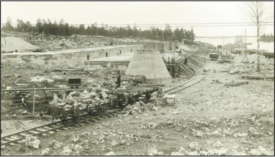
Här läggs grunden till det blivande koksverket. Bilden är tagen den 30 oktober 1914.
