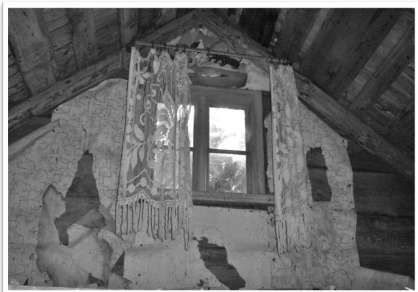
Vindsrum. Tapet direkt på timmervägg. Obs, en gardin!
