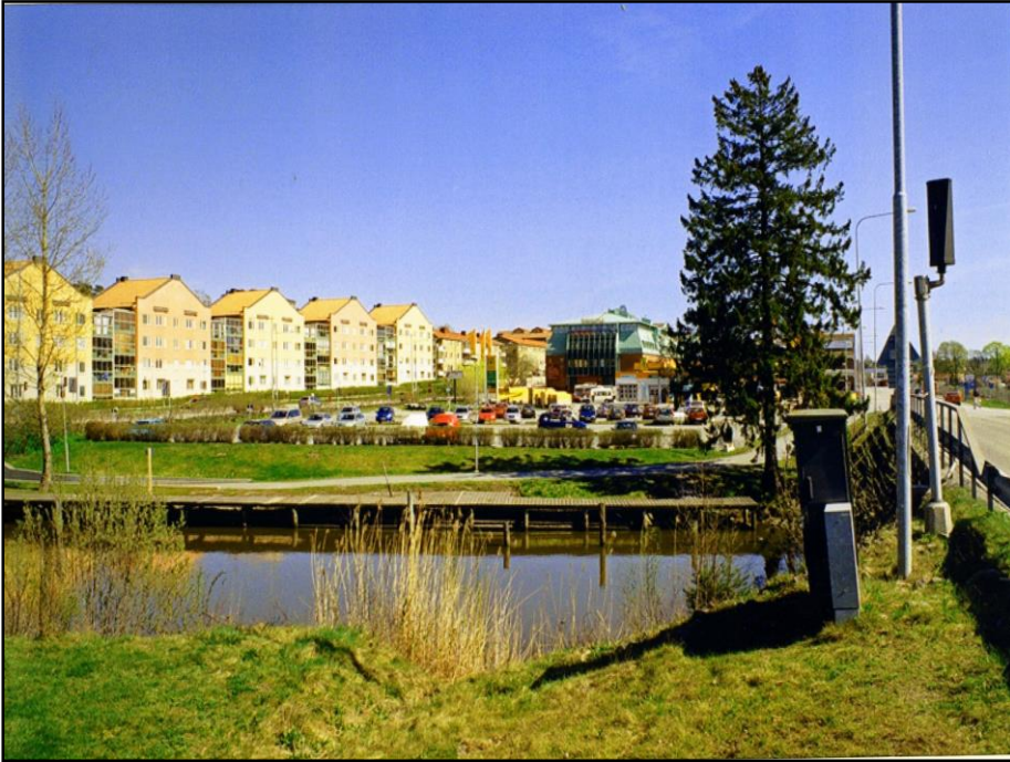
Bron över kanalen vid Stationsvägen. Folkets hus III, bebyggelsen vid Thuns väg.
