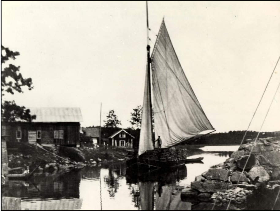
Den vedlastade skutan Alcea (kommunvapnet!) är här på väg in i kanalen ifrån norr. Bron är borta, vi ser bara rester av fundamenten på båda sidor om kanalen.
