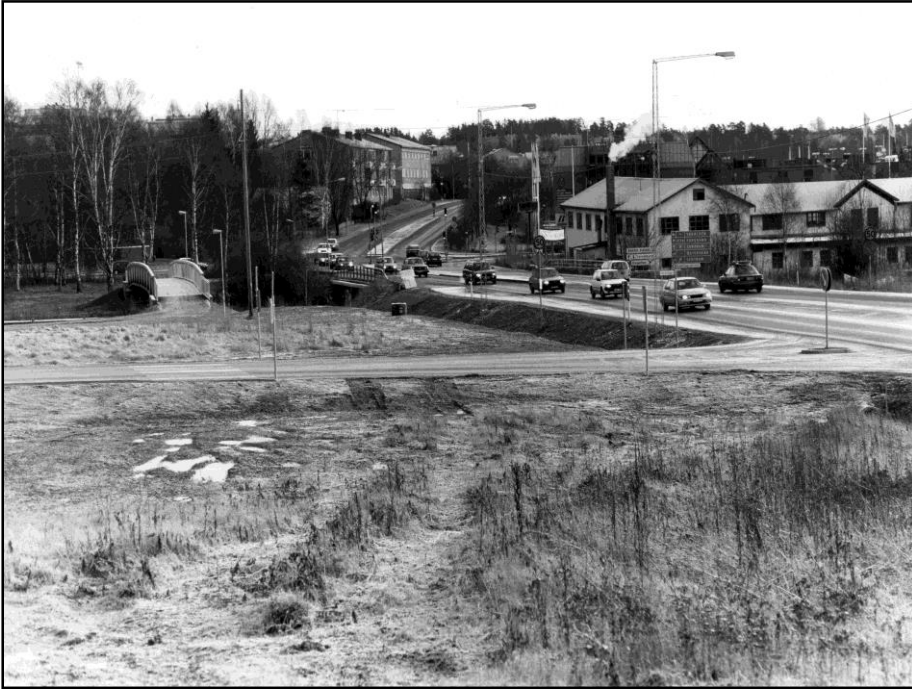
Väg 276 över Åkers kanal. Till höger Snickerifabriken och de sista resterna av Kahnlunds "imperium". Roslagsvägen går fortfarande över en backe i centrum, ingen tunnel har ännu byggts.
