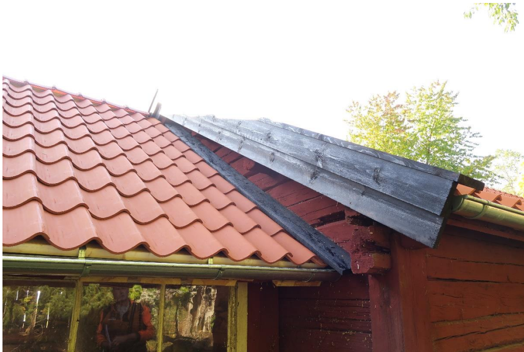
Baksidan av loge/ladugård. Nya vindskivor är monterade.
