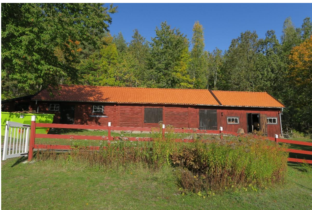
Ladugården och loge från håll, efter renovering. En svarttjärad bräda har monterats för att visa de olika delarna.
