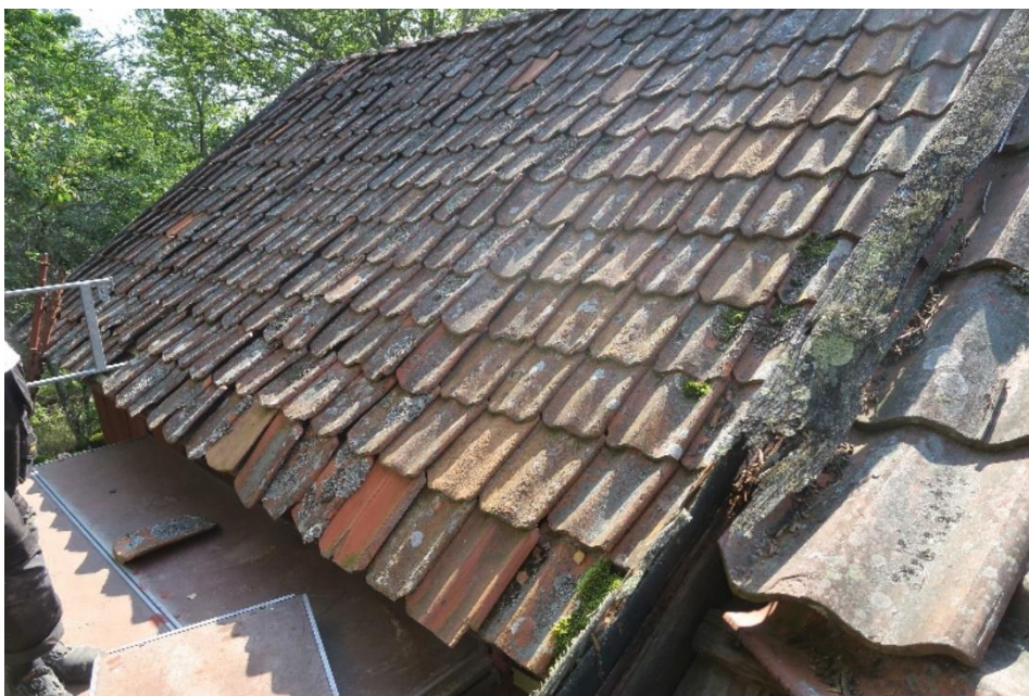
Baksidan mot nordöst. Tak inför renovering. Den äldre delen hade ett flertal tegelsorter. Taket hade kompletterats med tvåkupigt lertegel. Mot höger i bild ser man skarven mot den logdelen.
