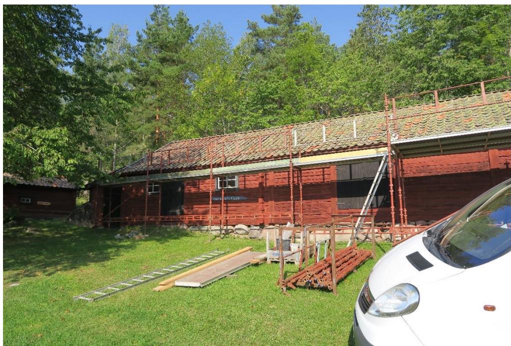
Logdelen mot väst med byggnadsställning monterad.
