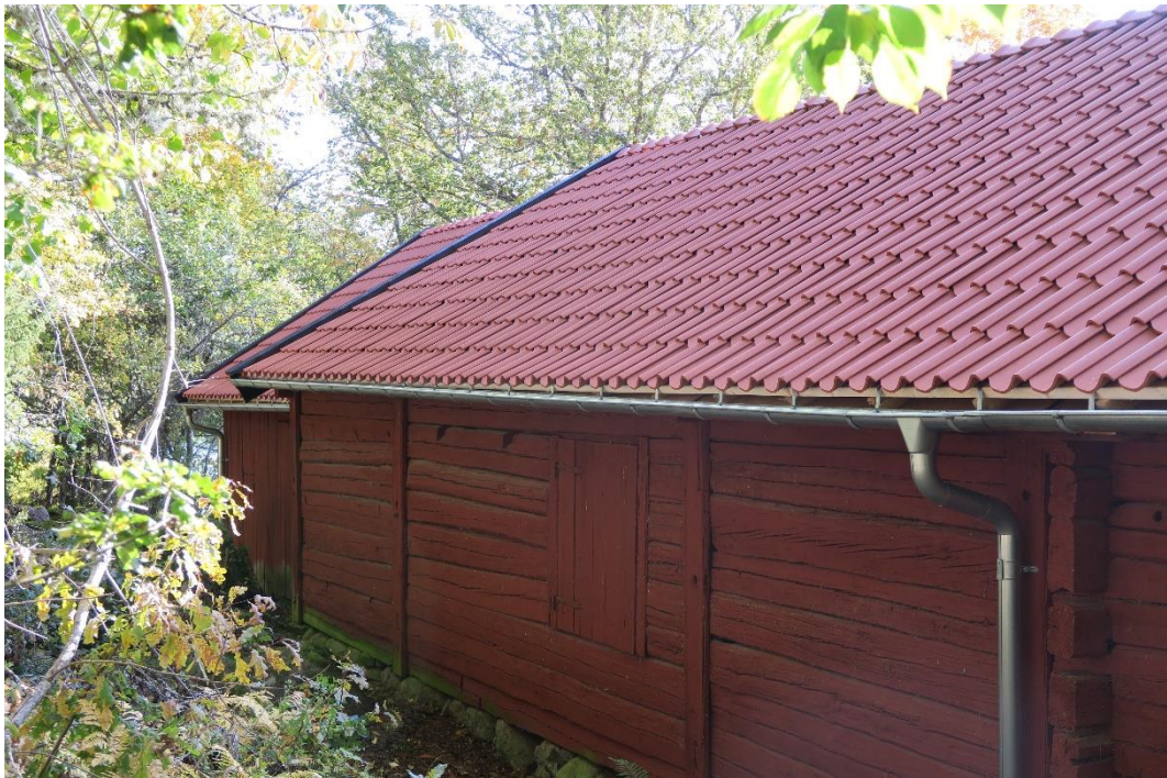
Ladugårdens baksida. De två olika nivåerna är extra märkbara här. Nya vindsivor och vattenavrinning.
