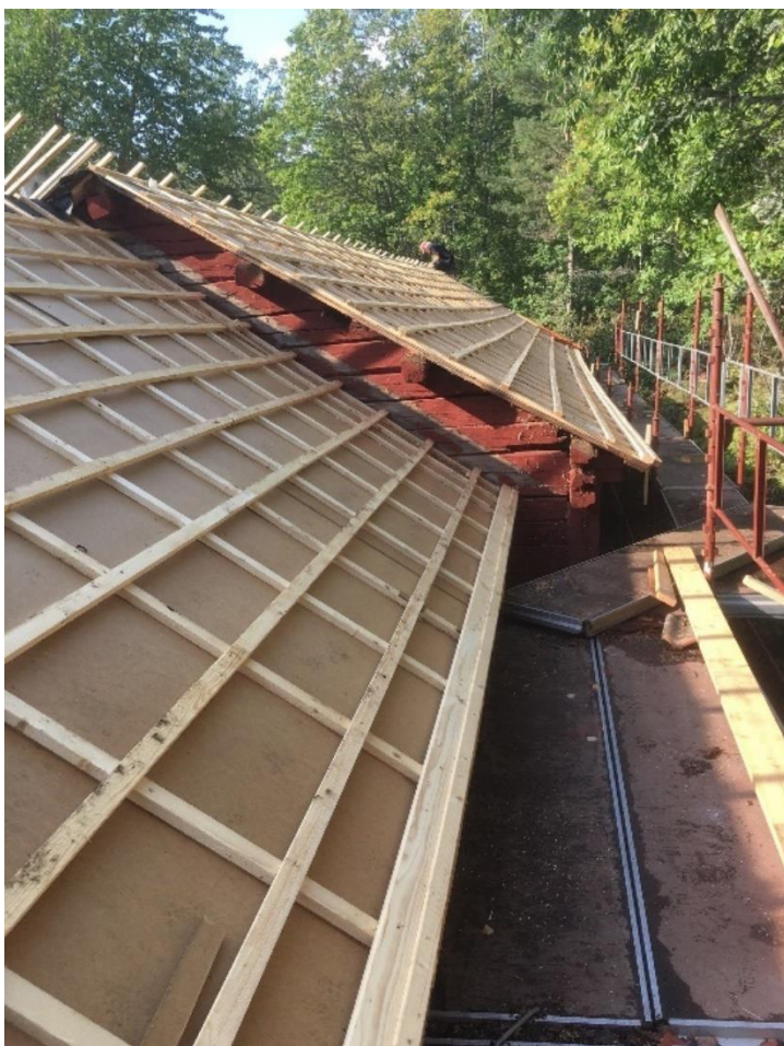
Taket har riktats. Ny Masonite och takläkt monterad på logens baksida. Foto: Sören Pettersson,
