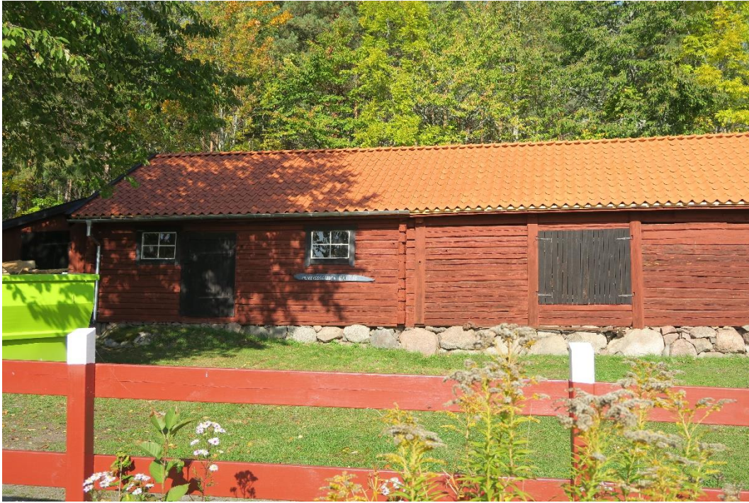
Ladugårdens västra del, efter renovering. Över ingången är ny hängränna monterad, där också stenfoten är lägre. Över mittenpartiet monterades ingen hängränna då stenfoten var så pass hög.
