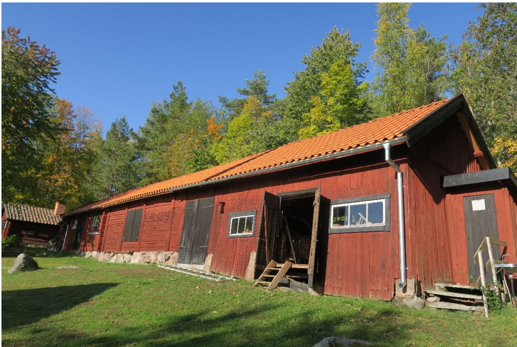
Mot öst är ny hängränna och stuprör monterad. Dasset mot öst ska inom snar framtid också få nytt tegeltak.
