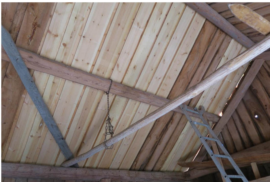
Den äldre delen var i störst behov av nytt undertak. Vissa brädor är återanvända.
