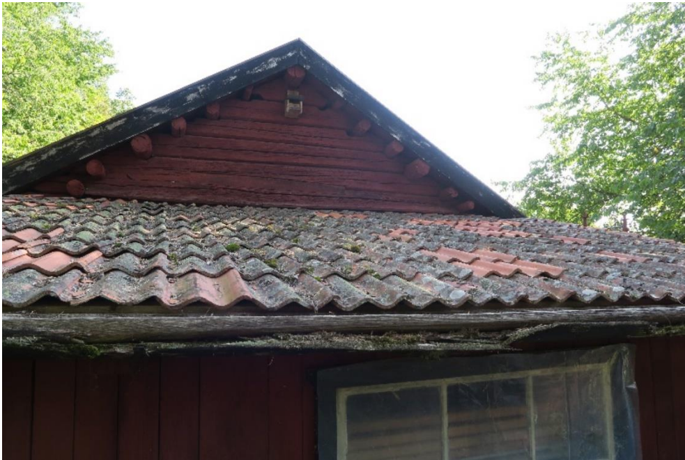
Logens mindre del mot väst inför renovering. Tvåkupigt tegel och hängränna i trä.
