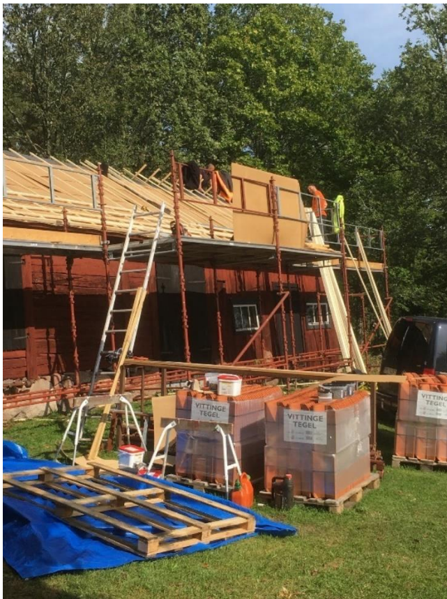
Ett nytt undertak med Masonite och läkt monteras. Nytt tegel (Vittinge) på plats. Foto: Sören Pettersson
