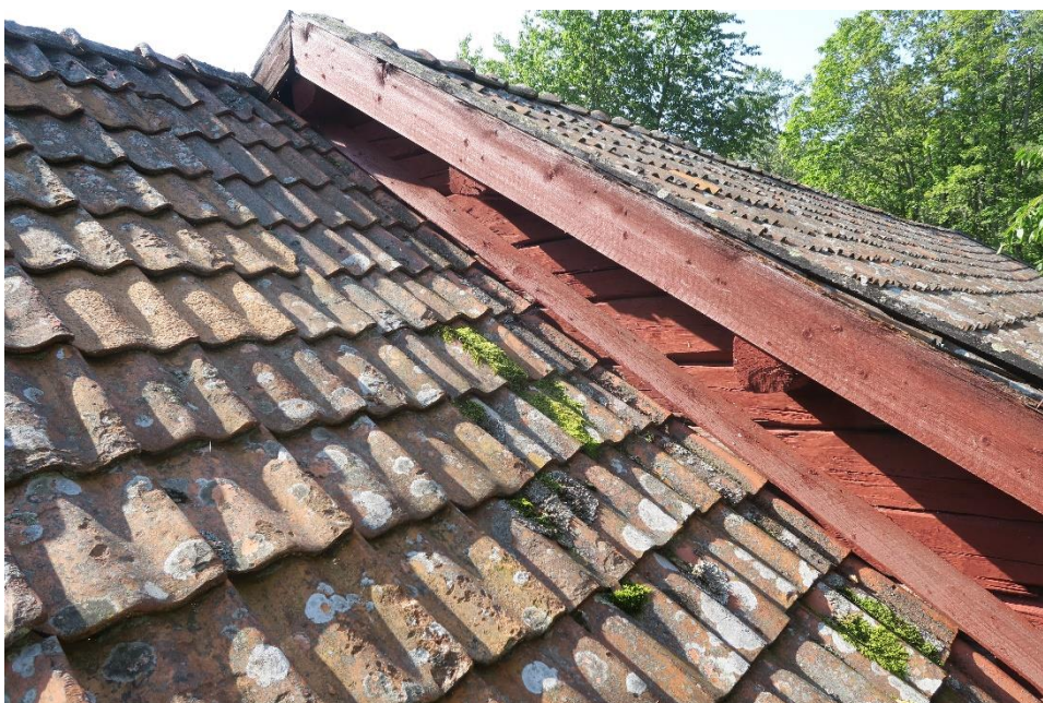
Baksidan mot sydväst. Tak inför renovering. Den äldre och nyare delen.
