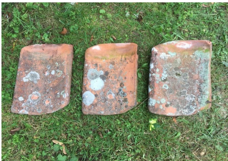
Vid sortering av takpannor fann föreningen flera sorter och storlekar. Till höger i bild; ca 28 cm breda, i mitten; en mindre och lite kupigare sort ca 25–26 cm breda, till vänster; en mycket flat sort som även är tunnare och "spetsigare". Foto: Sören Pettersson.
