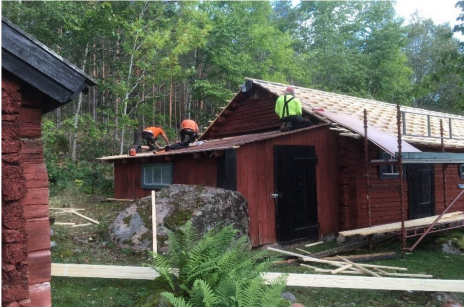
Lagning av tak mot väst. Bröderna Storm under pågående arbete. Foto: Sören Pettersson
