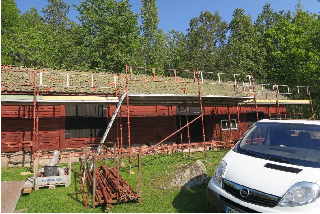
Logdelen mot öst med byggnadsställning monterad.
