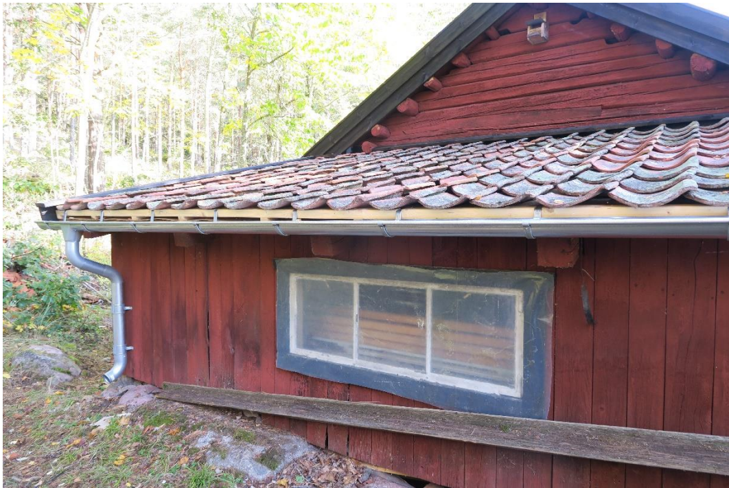
Ny hängränna och stuprör är monterad på utbyggnaden på kortsidan mot väst. Teglet är återanvänt från ladugården.
