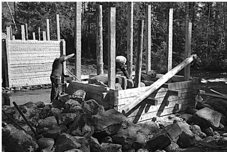
Hantverkare från Gallejaurl-Järvlia kulturbyggsförening utförde restaureringen.
