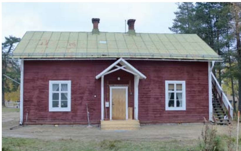
Gamla telegrafan efter renovering.
