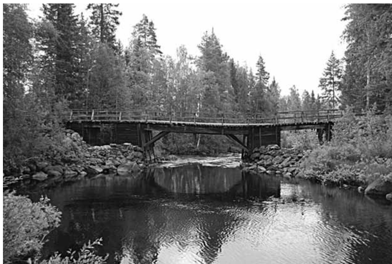
Så såg bron ut före den omfattande restaureringen.
