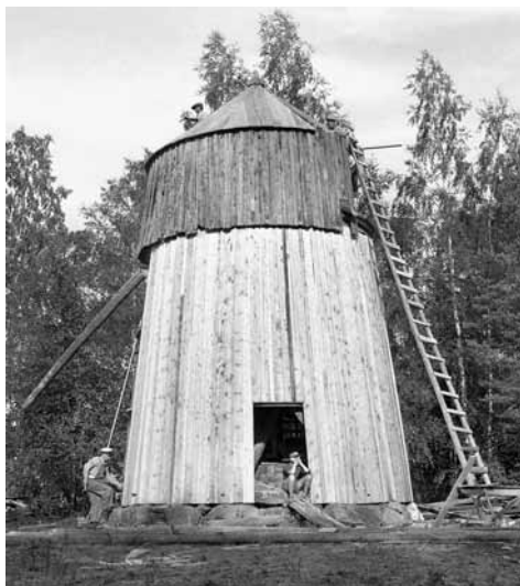
Den gamla hattkvarnen på Junkön färdigställdes genom föreningens försorg 1949. Större delen av vskärgårdens öar tillhörde Nederluleå socken. Foto: Arvid Moberg, Luleå kommun, Stadsarkivet.
