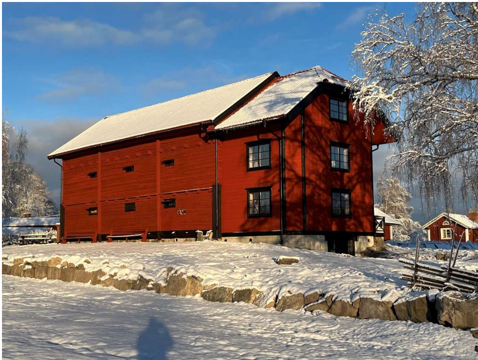
Bygge klart yttre arbeten dec 2024. All yttre målning egen regi
