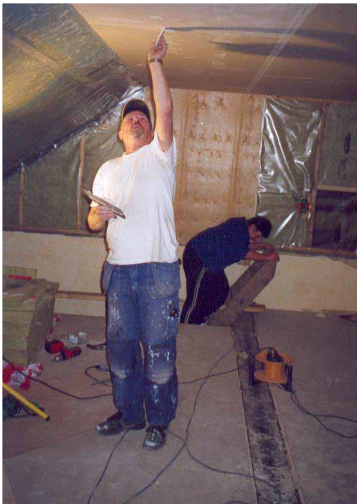
Här spacklas och skruvas på vindsvåningen.
