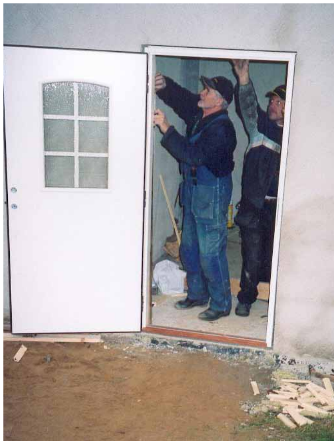
Bengt Nilsson, Torsten Håkansson sätter i ytterdörren
