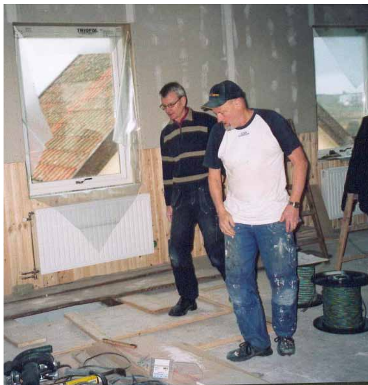
Sten Tell elinstallatör, Mats Mårtensson.
