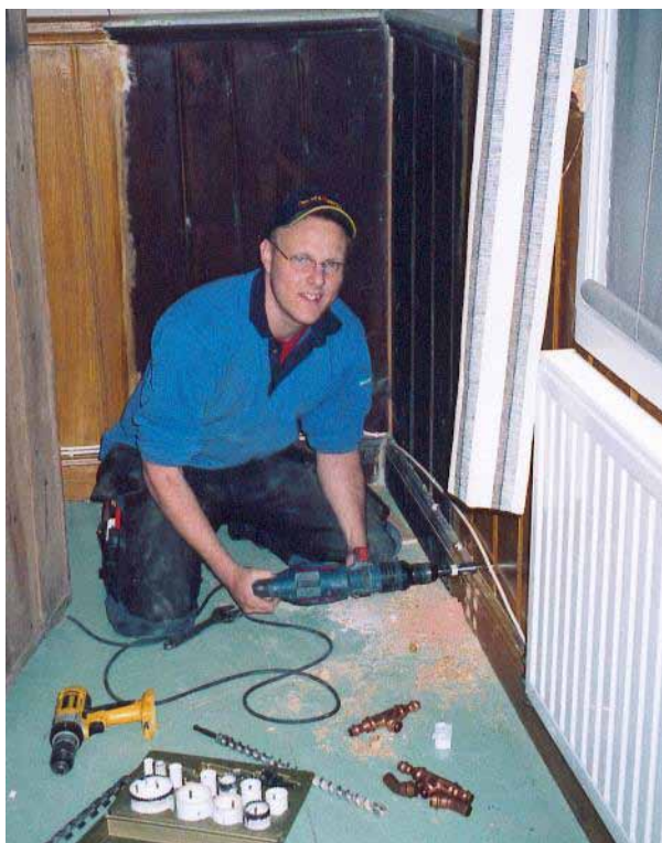
Andreas Andersson, värmeledninginstallation.
