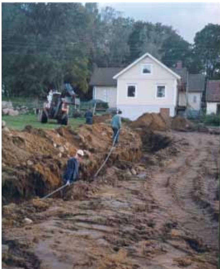
Oktober 2006 grävdes jordvärme.
