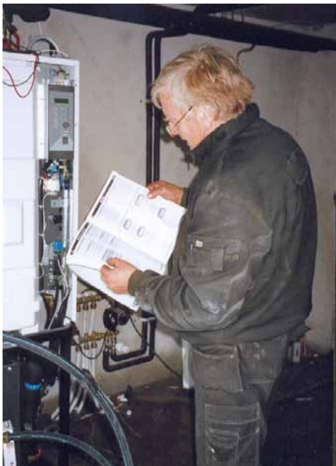
Gunnar Karlsson installerar värmepumpen
