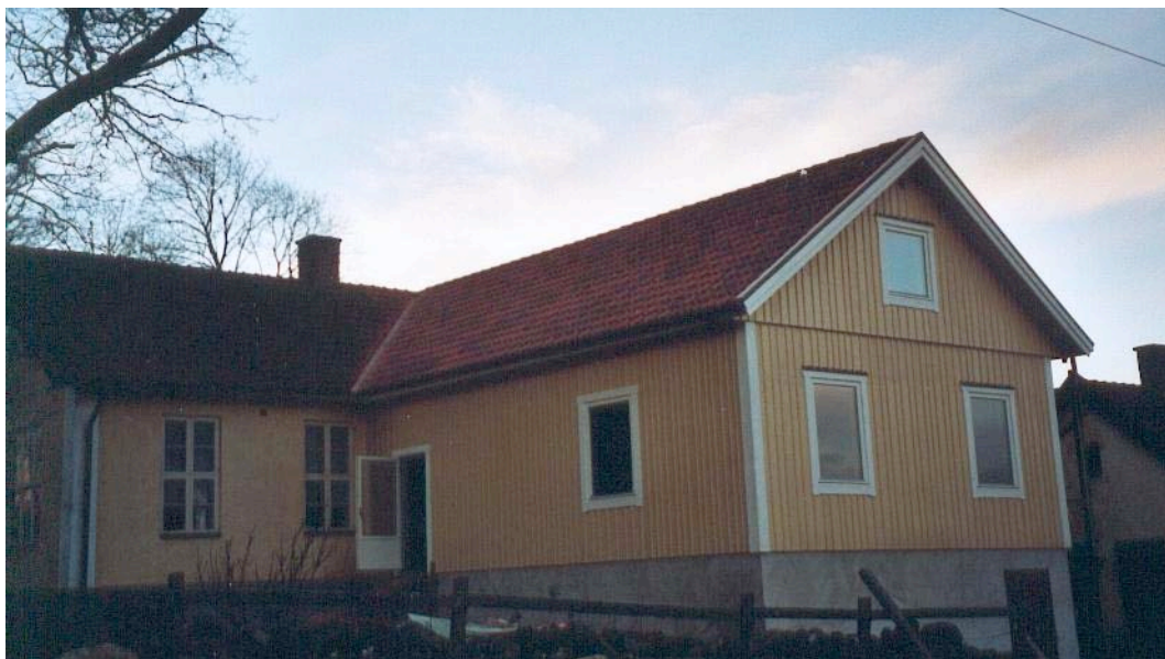
20 december 2005 ytterväggar, fönster och tak klart.
