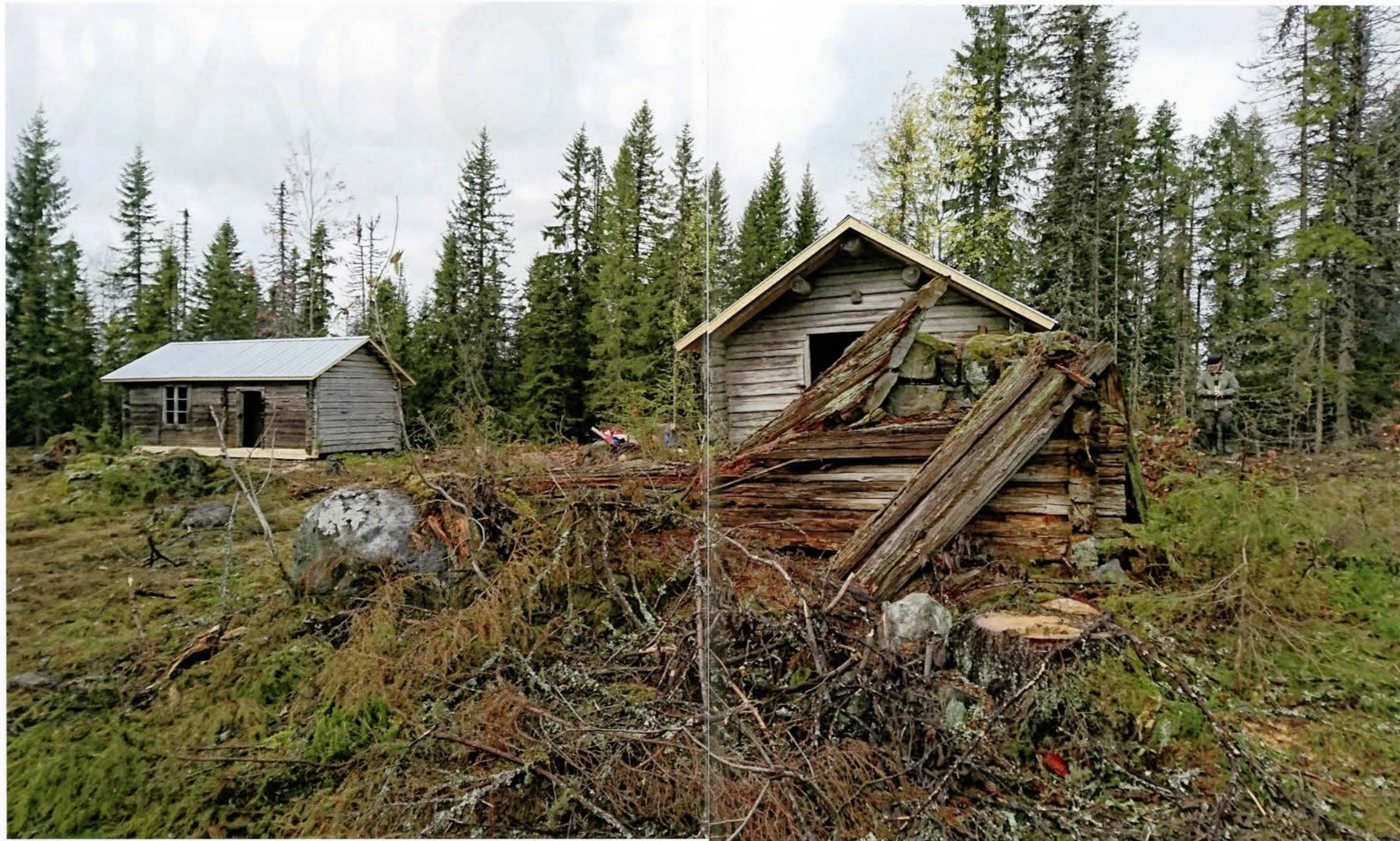
▲ Kokhuset fick nya bottensyllar och nytt tak och golv. Foto: Marie Hellstrand
