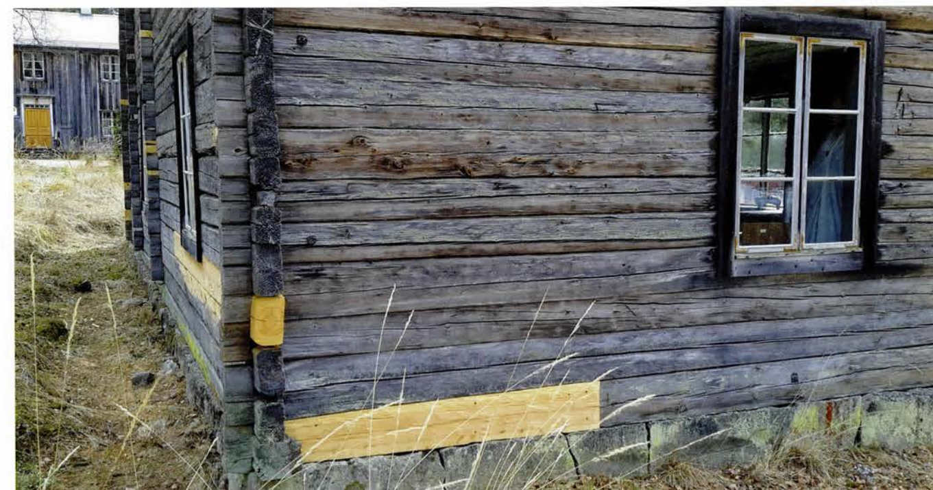
Reparation på hembygdsgränd i Borgsjö. Foto: Ing-Marie Ångström.
