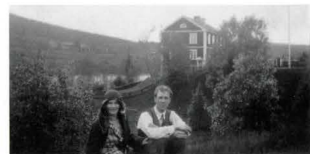
Artur och Hildur Norlén vid platsen där lärarbostaden skulle byggas.
