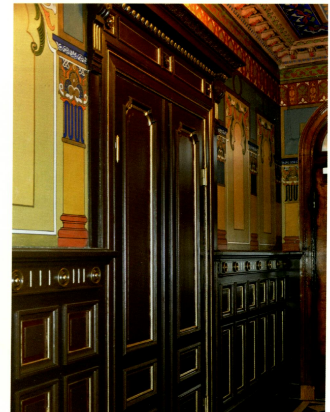
Vy från yttre entrén. Efter åtgärd.
