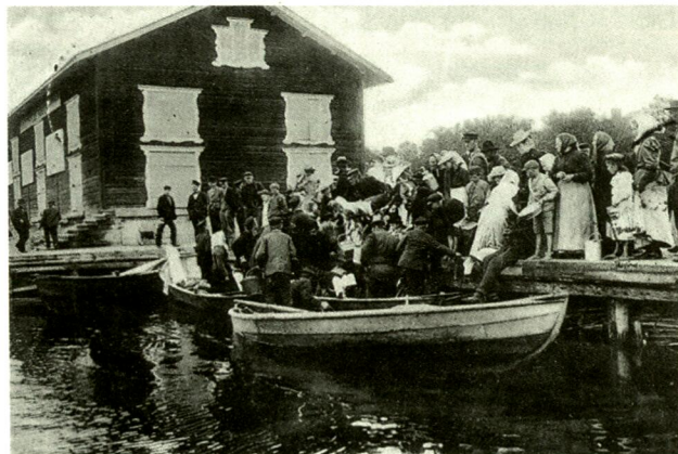
Folk har samlats på bryggan i hopp om att få köpa strömming, omkring 1917. Bilden utlånad av Torsten Sundin.
