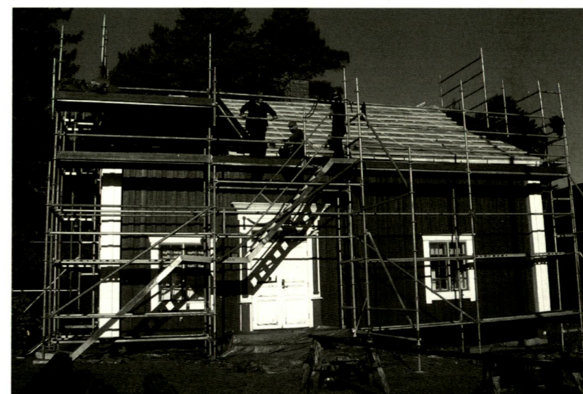
Strömnäsgården får nytt brädtak/faltak. Foto: Bodil Mascher
