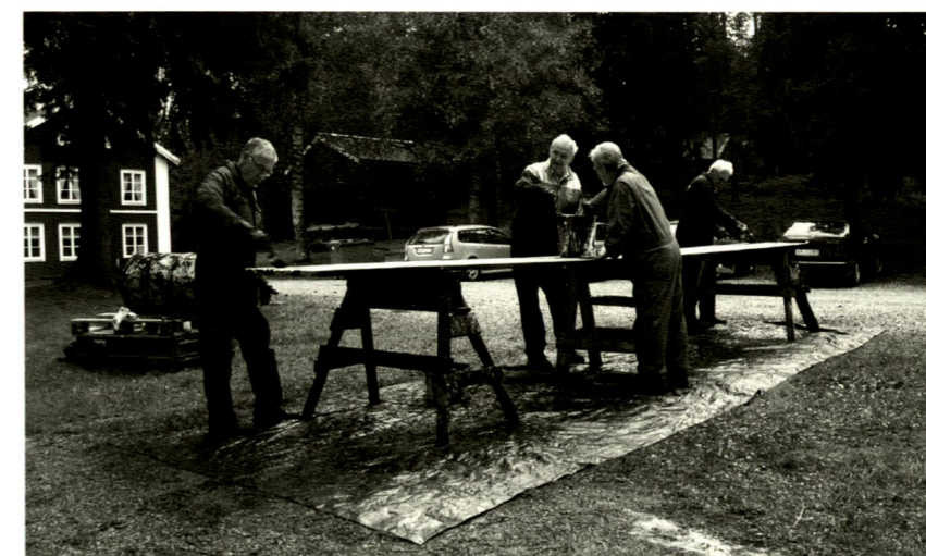
Börje Eriksson och ett gäng medhjälpare behandlar de nya takbräderna med tjära blandad med terpentin och rå linolja. Foto: Bodil Mascher.
