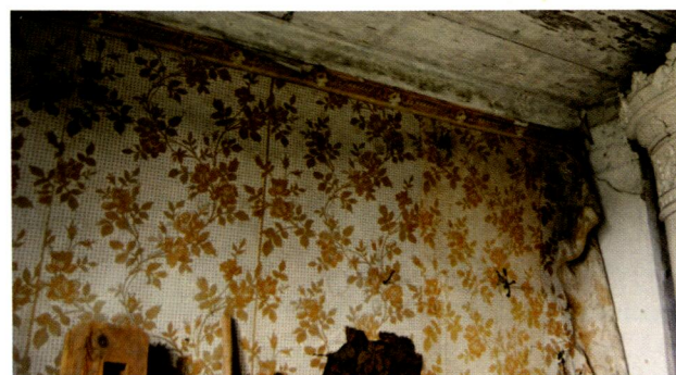
Bilden visar tapeten i kammaren innan taket målades om och tapeten lagades. Den bit som hänger ner till höger vid murstocken använde vi att laga med. Hålet mitt i bild lagades med mönsterpassning.
