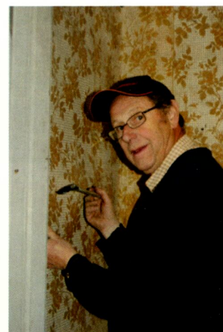
Många lager som behöver spikas i vägg sedan limmas lager för lager och slutligen lagas ytterst. Sören spikar och limmar fast en tapetbit i kammaren.
