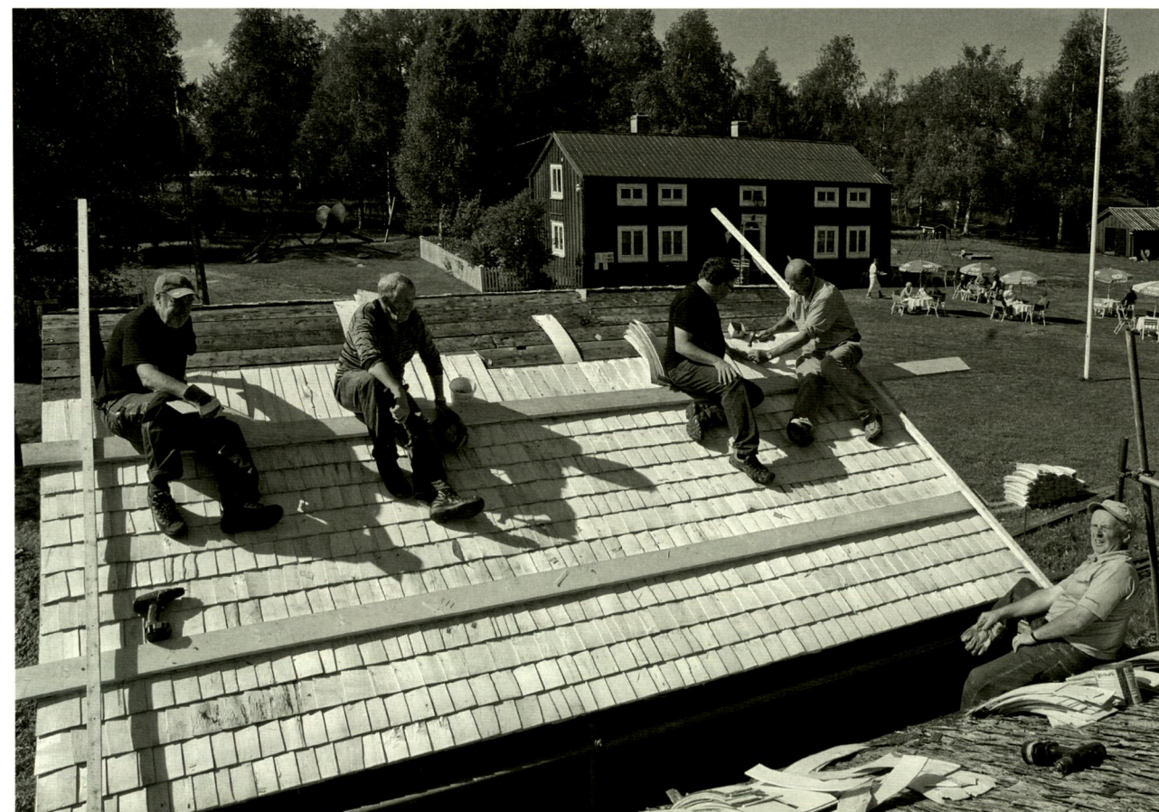
Varje sommar lockar Grundsunda hembydsgård med kaffeservering och våfflor. Om årets besökare på gårdstunet höjde blicken såg de ett idogt gäng som jobbade med sockenmagasinets spåntak. En värdefull men obetald insats som tog två veckor. Foto Staffan Norstedt
