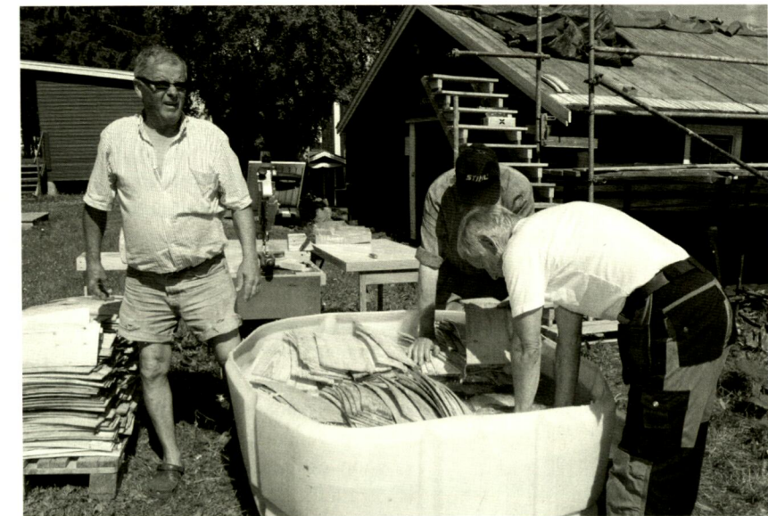
Attmars hembygdsgård. Spånläggning på stall och härbre. Foto Johanna Ulfsdotter.
