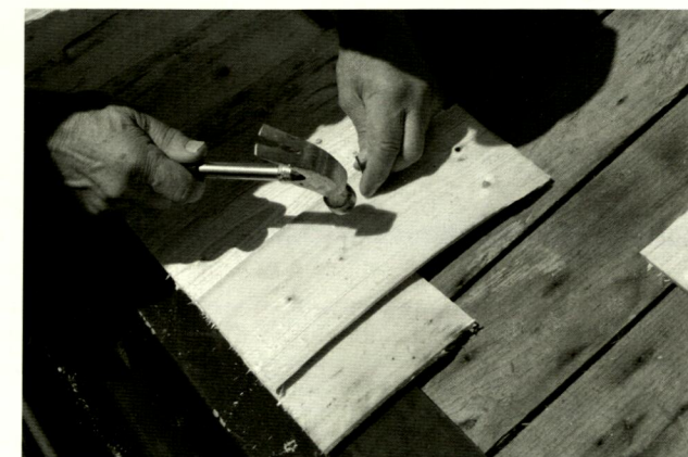
Spånläggningen börjar vid takfoten. Foto Johanna Ulfsdotter.
