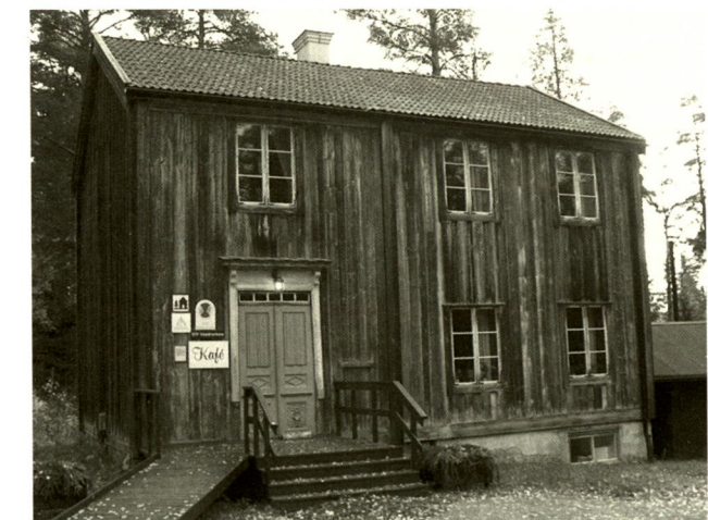
Tingshuset på Borgsjö hembygds gård. I källaren till höger finns hembygdsarkivet med betongvalv och ståldörr som har byggts enligt gällande arkivkrav.
