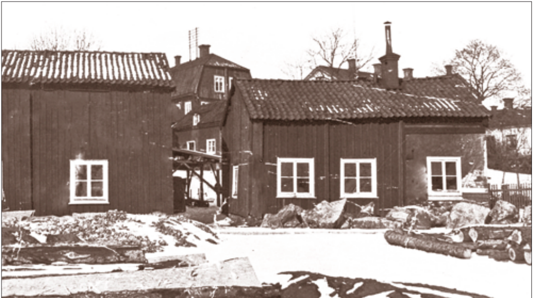
Strandvägen 11. Till vänster: J. A. Kihlboms garveri i gård 83. Till höger: F. U. Bomlers tvättstuga och gamla smedja i gård 84. Foto: Okänd: Omkring år 1900.
