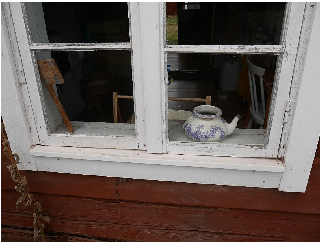
Idastugan. Köksfönstret med moderna foder och en skyddande list för möss!
