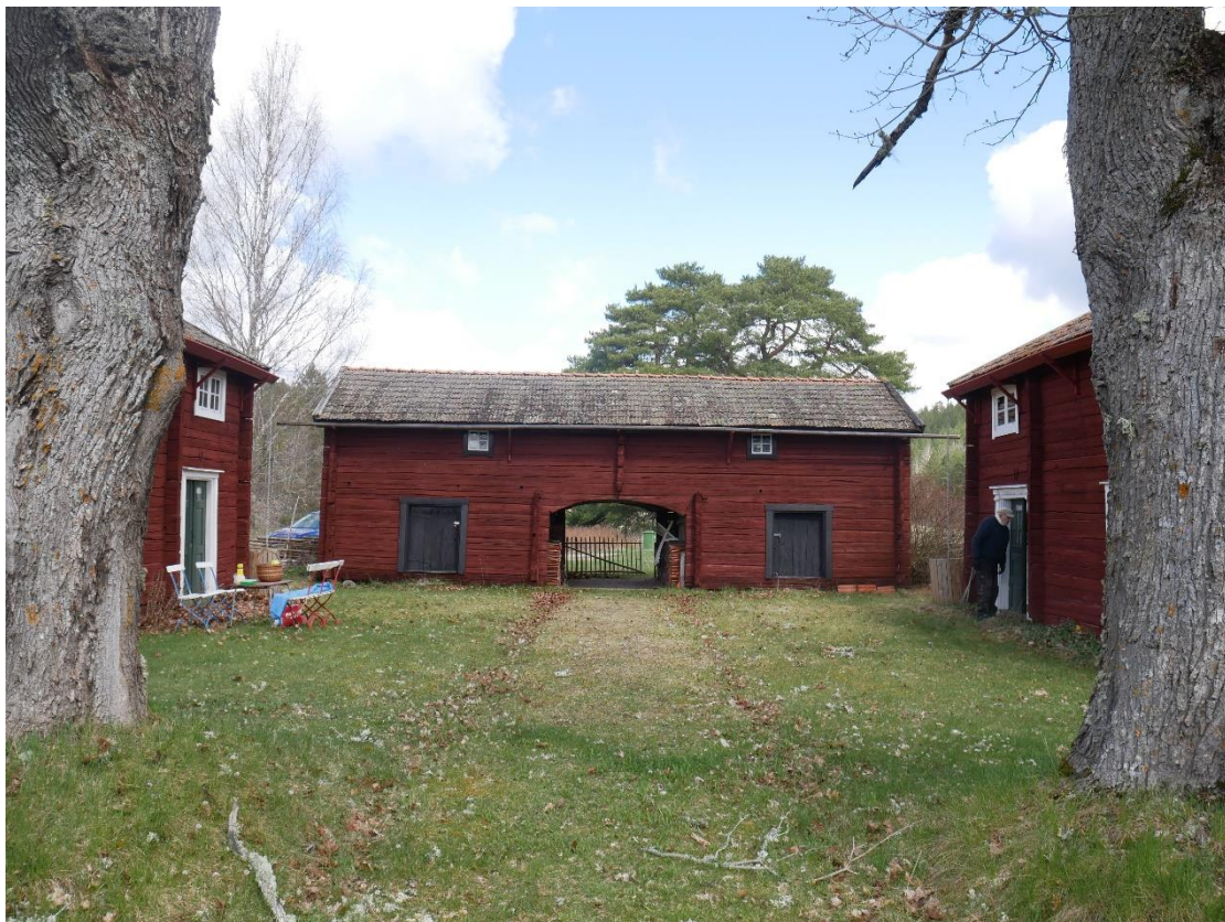
Mangården med portlidret som det i dag gestaltar sig. Bräddörrarna och omfattningar är svartmålade vilket utfördes på rekommendationer från Östergötlands länsmuseum 1968.
