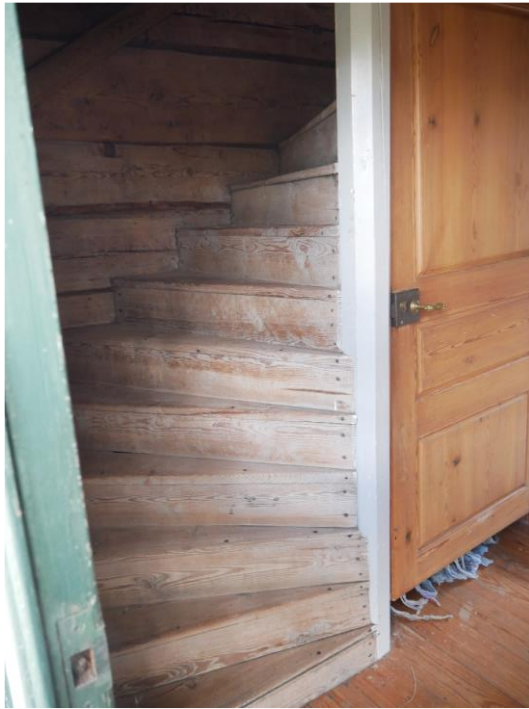
Trappa till övervåningen.
