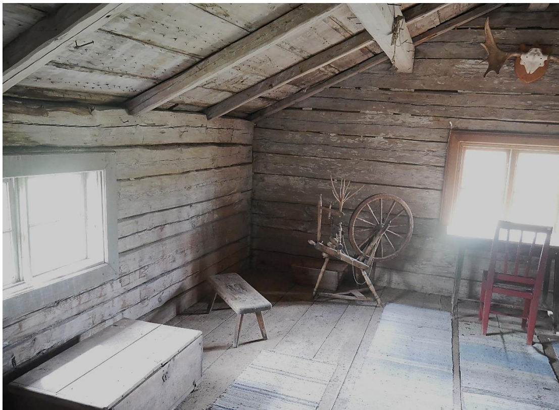
Huldastugan, övervåningen. Konstruktionen är synlig i såväl väggar som tak.
