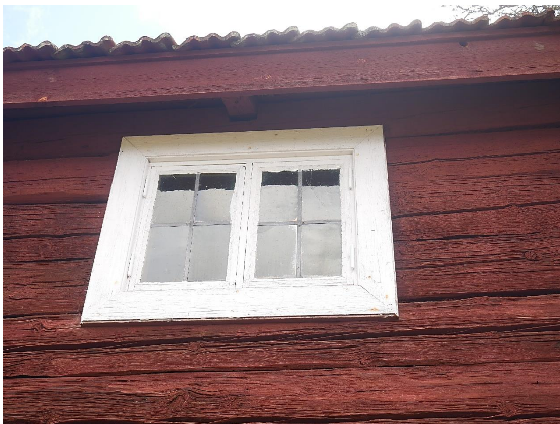
Idastugan. Blyinfattat fönster. Foder med gerade hörn.
