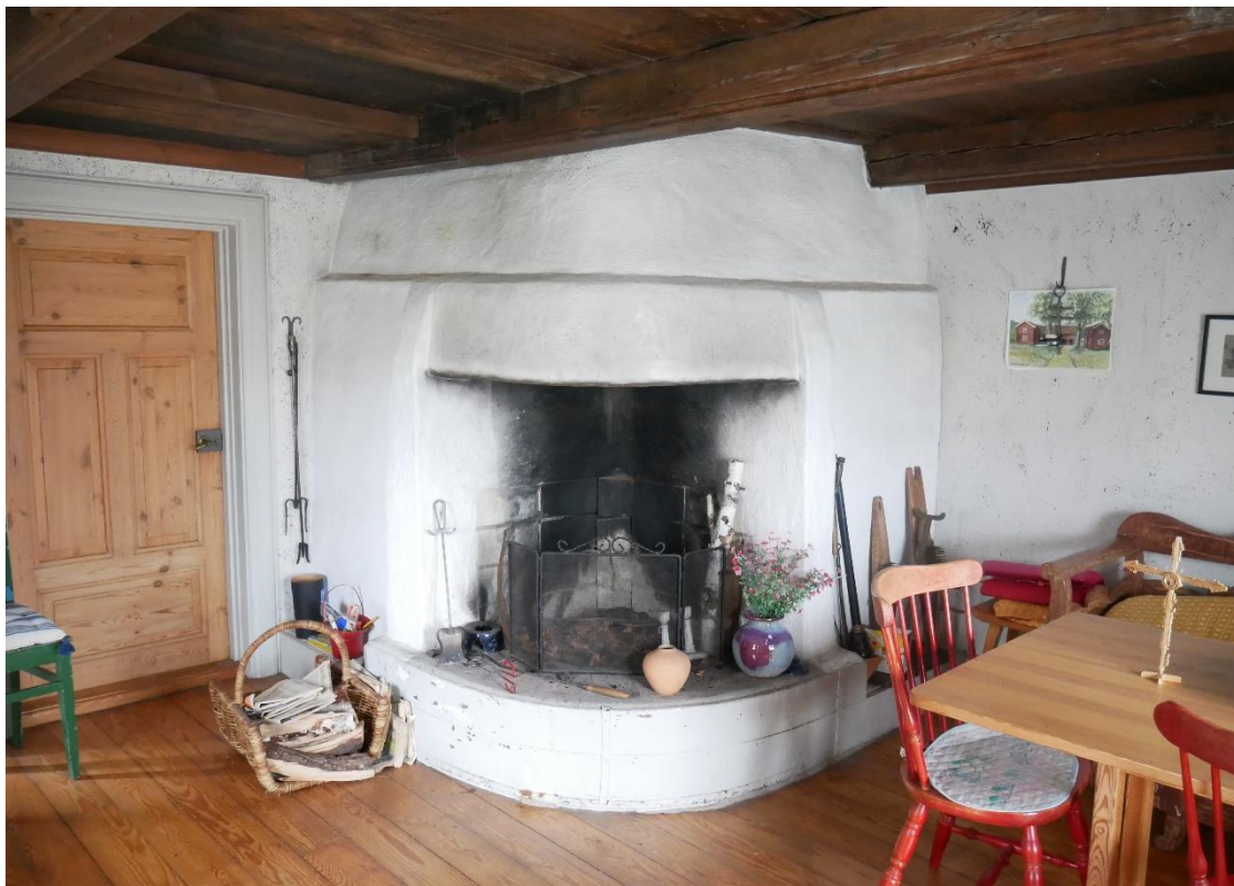
Stugan med den stora öppna spisen som har ett bevarat svep. Ny dörr och nytt golv. Väggarna är isolerade.
