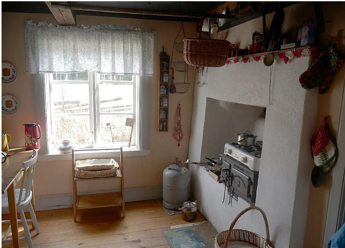
Köket med bakugn och järnspis. Väggarna är inklädda och golvet nytt.
