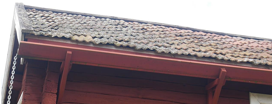
Huldastugans östra takfall.
