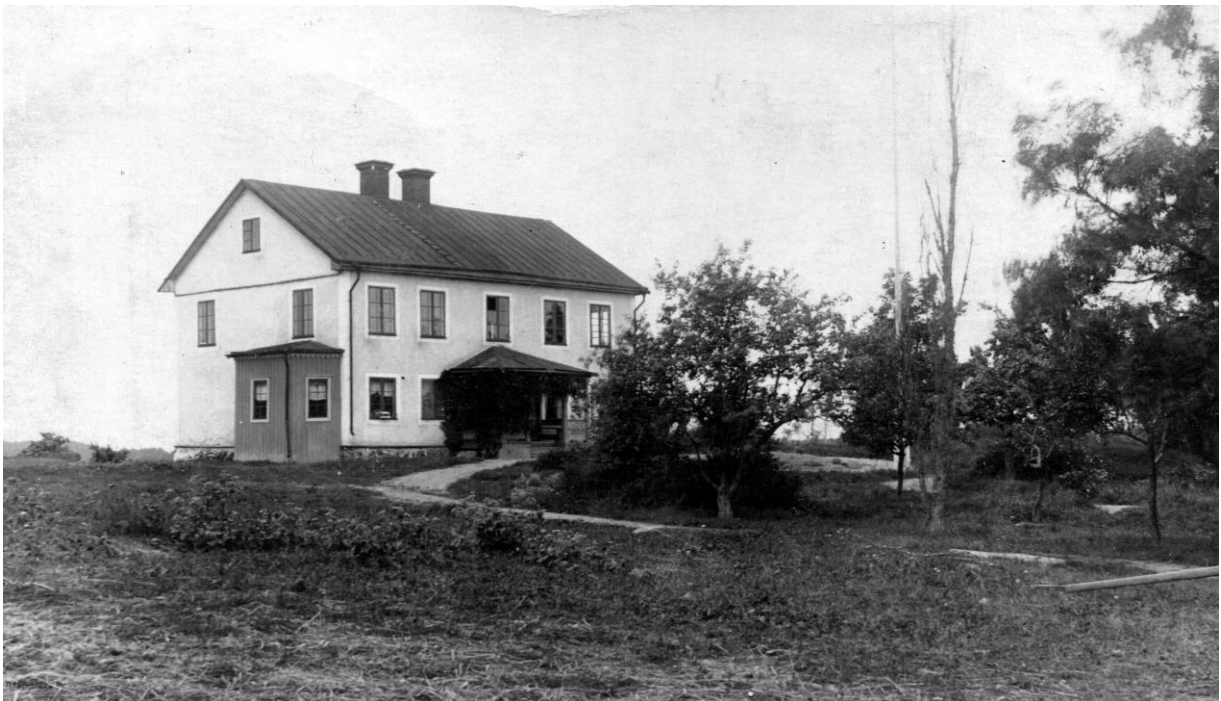
Hacksta före elektrifiering okänt årtal
