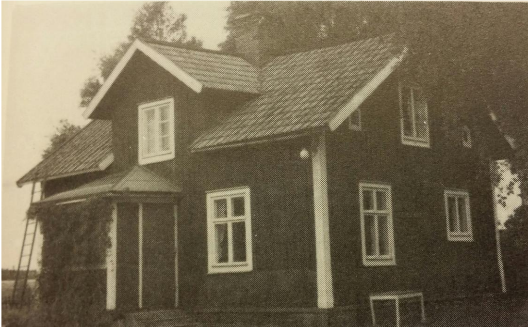
Mangårdsbyggnad ifrån c:a 1880- talet
