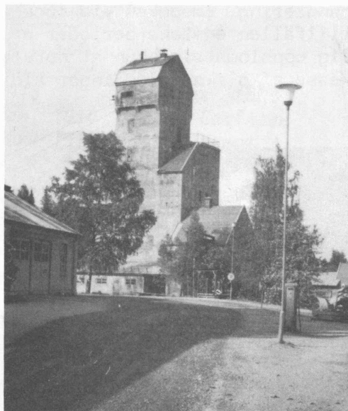
UPPFÖDRINGSANLÄGGNINGEN 1918 "STÄHLES SCHAKT". Denna lave öfver Centralschaktet är en av de första i landet, som uppfördes i betong
