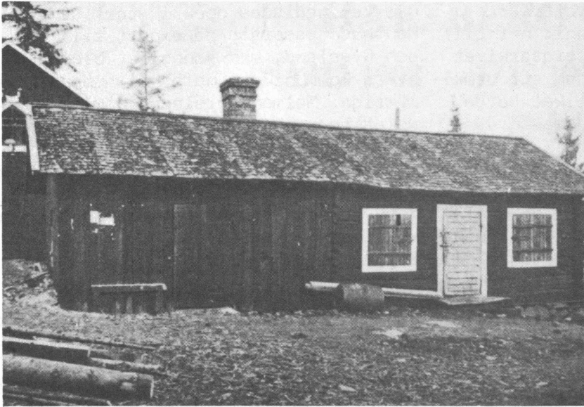
"SAMTLIGA ANLÄGGNINGAR" VID GRUVFÄLTET 1908 Bygganden innehöll kontor, gruvstuga och smedja. Byggnaden i bakgrunden är av senare datum.
