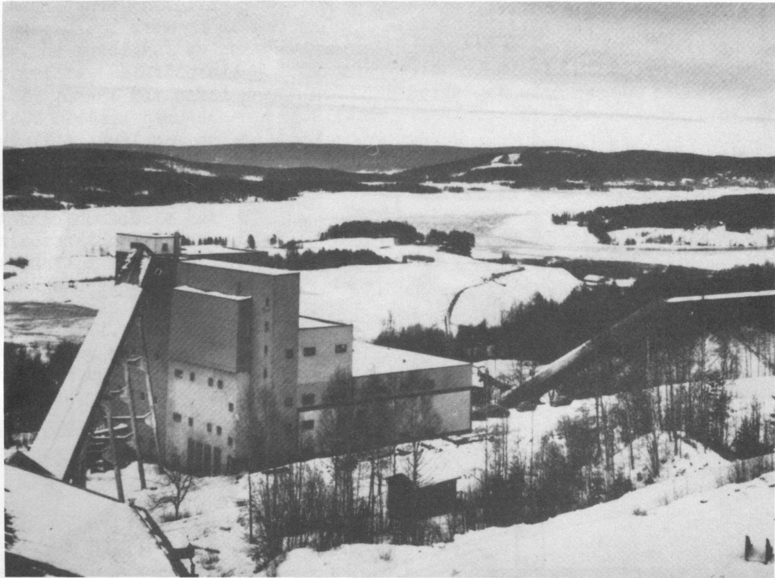
NYA ANRIKNINGSVERKET BYGGT 1956 - 1957
