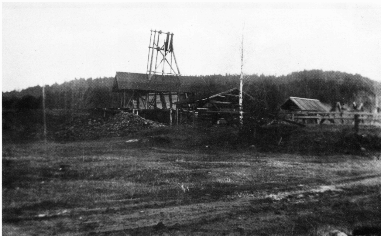
Bild 17. Östanbergsgruvan med stånggång, konstbrott och uppforderingsanordning.
