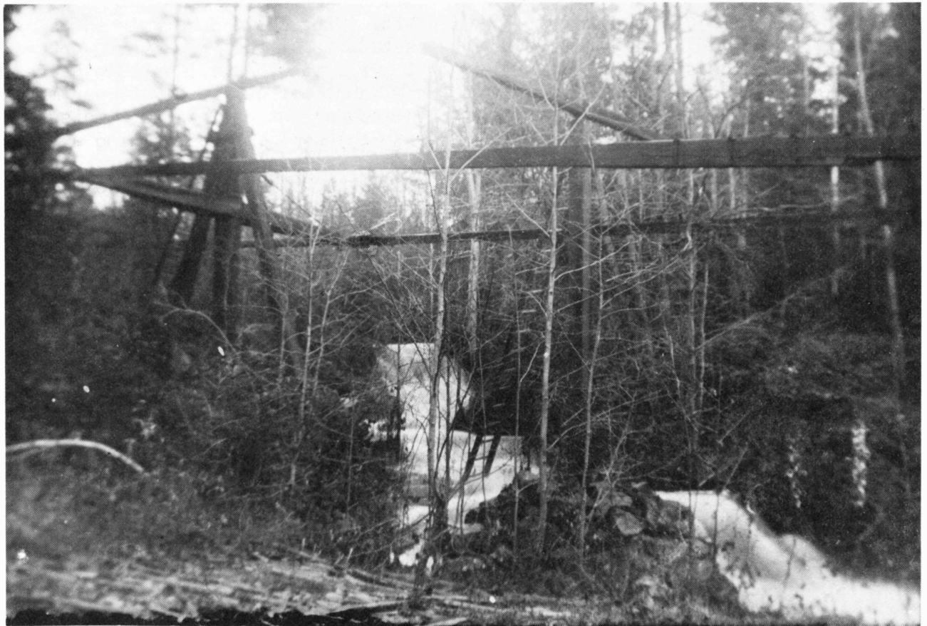
Bild 13. Konstledningen eller stånggängen vid Östanbergs Gruvfält.
