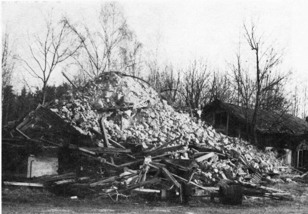
Norsbro kalkugn efter rivningen år 1977. Foto 12 - 141 : 21.
