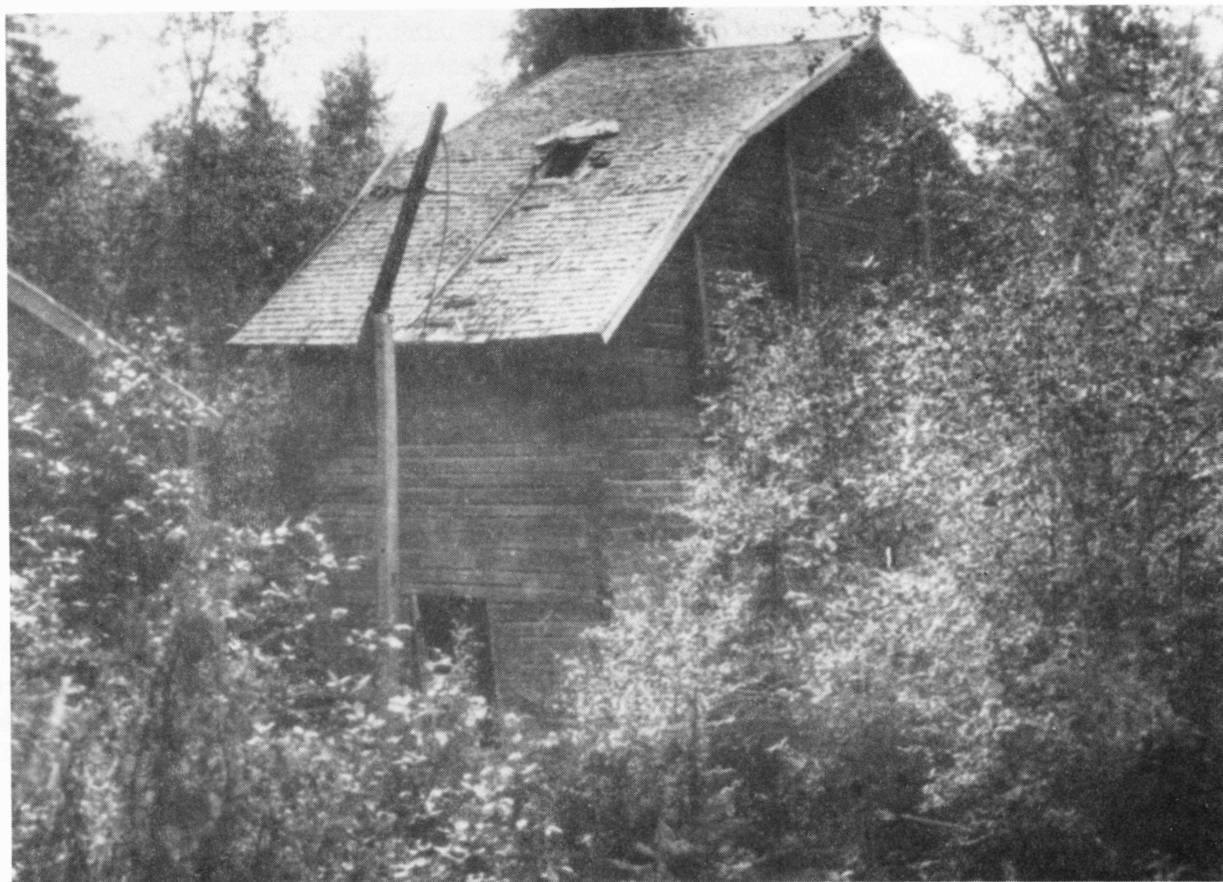
Bild 8. Östanbergshjulets hjulhus med spår av vattenrännor nederst till höger.
