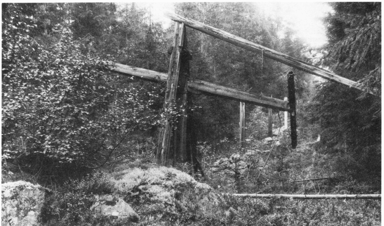
Bild 14. Rester av konstledningen nära hjulhuset vid Östanberg.
