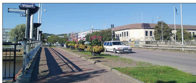
Västerbron, som sträcker sig över Bäveån i centrala Uddevalla, har skador som kräver reparation för att på sikt bevara bronns bärighet. I augusti påbörjas renoveringen, vilket innebär att framkomligheten kommer att påverkas kraftigt.
