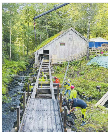
Rännan som leder vattnet från dämnet och in i kvarnen lyfts på plats.
