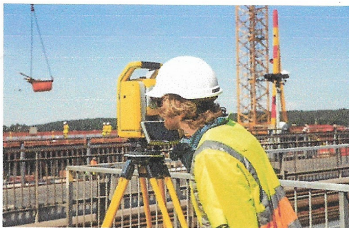
Trimble S 5 i bruk vid byggandet av Lilla Lidingöbron
