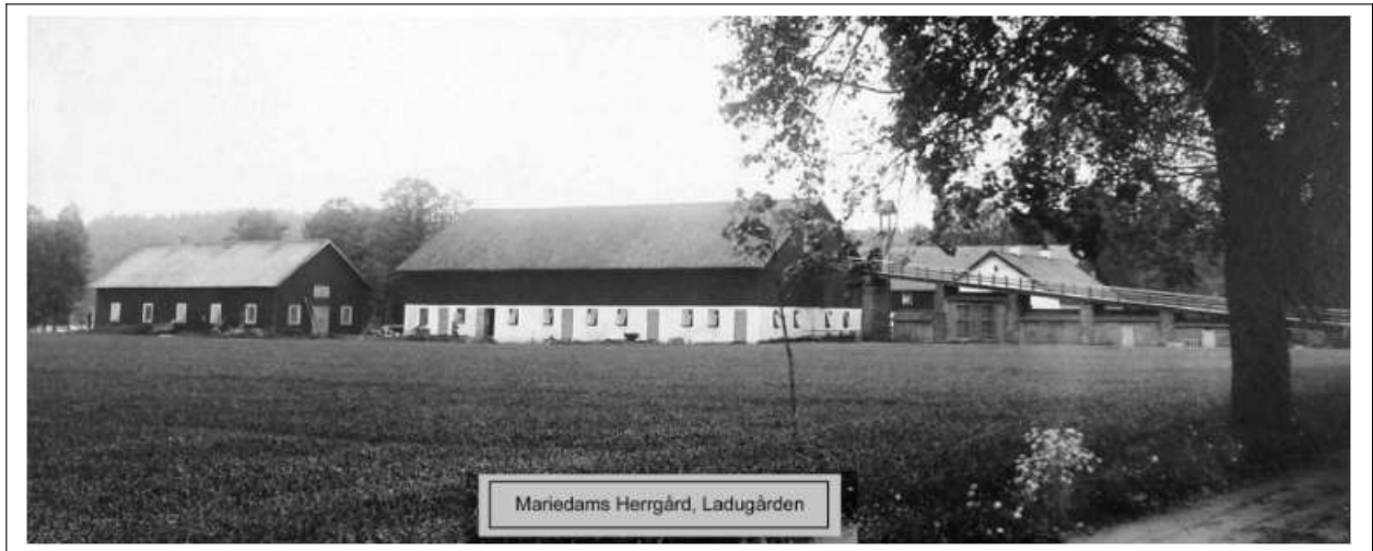
Ladugården (hus 31) i förgrunden och hus 33 (svinhuset) till vänster.
