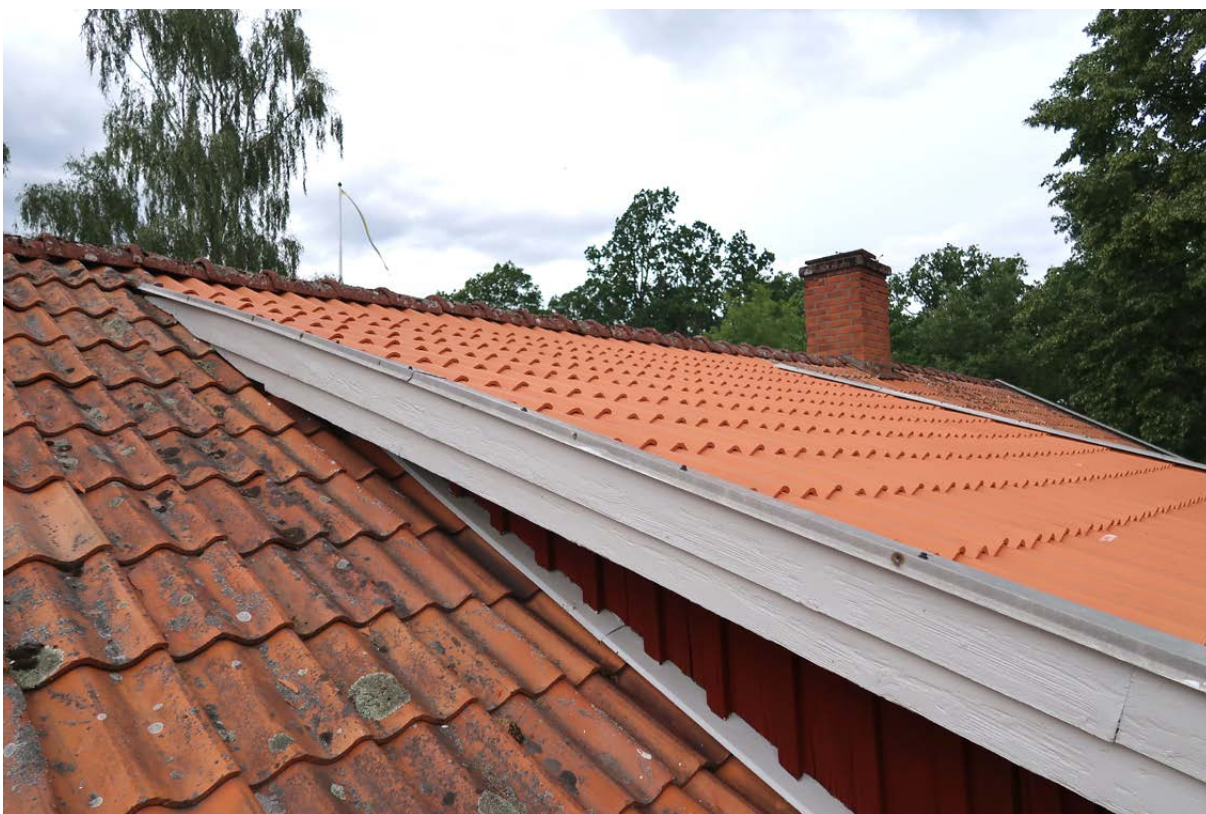
Övre delen av sydöstra takkupans tak efter åtgärd.
