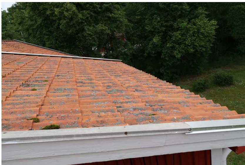
Nedre delen av sydöstra takkupans tak före åtgärd.
