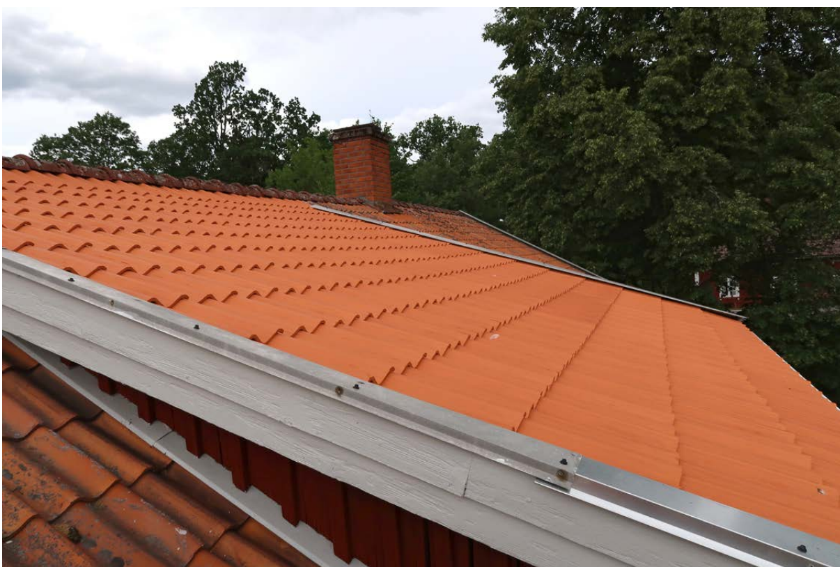
Nedre delen av sydöstra takkupans tak efter åtgärd.
