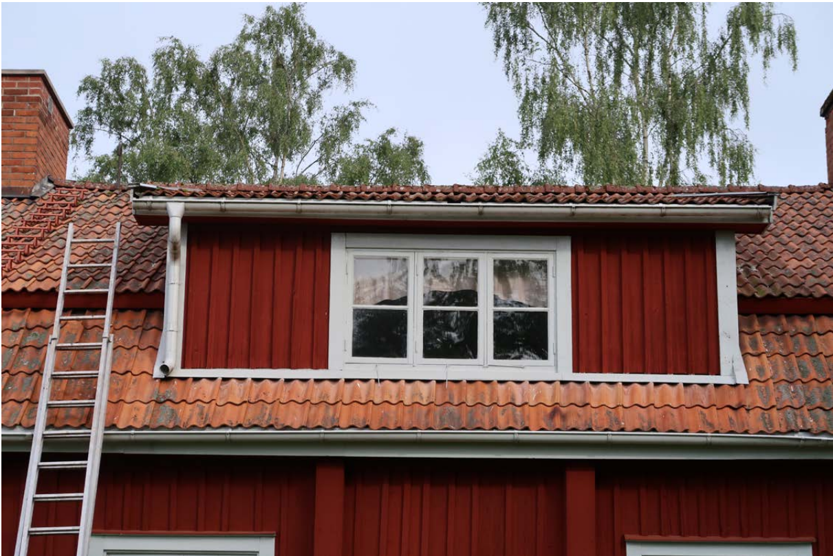
Sydöstra takkupan sedd från marken före åtgärd.
