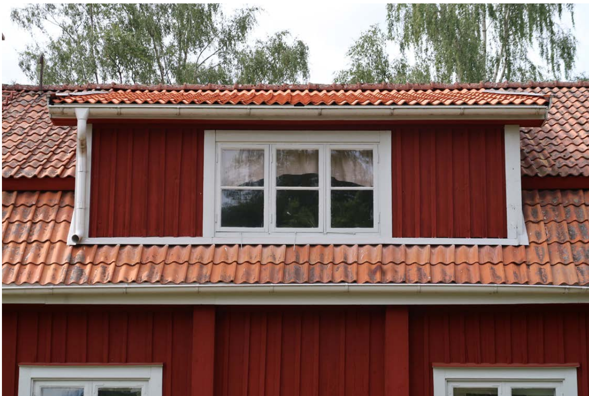
Sydöstra takkupan sedd från marken efter åtgärd.
