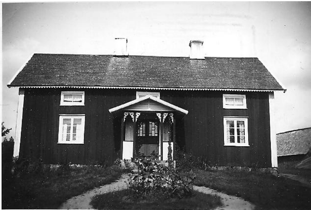
Bergmans hus, Stora Rya 1:5 efter renovering.
