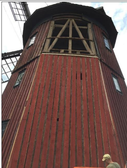
Ny fasadpanel har monterats på fasaden mot norr. Foto: Allan Rodbe, 2020-06-08
