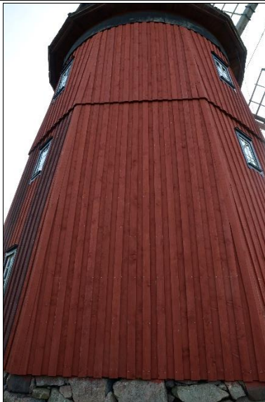
Nya panelbrädor på fasad mot väster. Foto: AP, 2020-09-17
