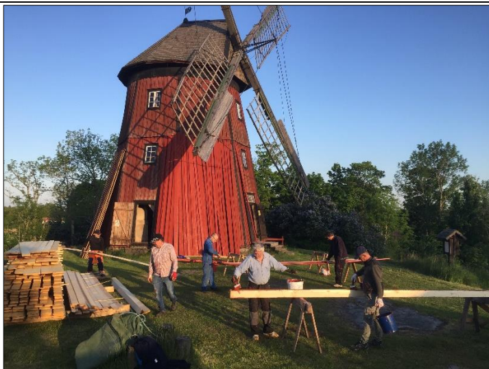
Lagga Hembygdsförening stryker panelbrädorna med faluröd slamsfärg. Foto: Allan Rodbe, 2020-06-04
