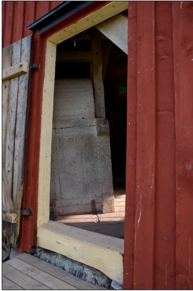
Ny yttertrappa, träskele och dörrkarm, dörr mot väster. Foto: AP, 2020-09-17
