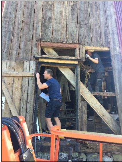
Dörrkarmen på dörr mot väster demonteras. Foto: Allan Rodbe, 2020-06-12
