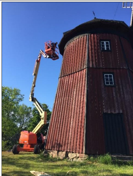
Påbörjat arbete på fasaden mot norr. Foto: Allan Rodbe, 2020-06-08
