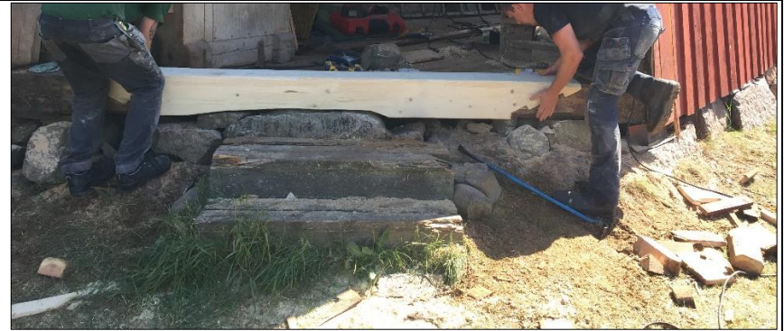
Ny syllstock och tröskel i timmer med blixtskarvar läggs på plats. Foto: Allan Rodbe, 2020-06-18
