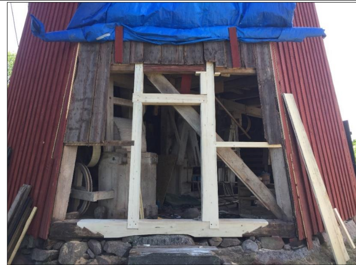
Ny dörrkarm och ny syllstock och tröskel vid dörr mot väster. Foto: Allan Rodbe, 2020-06-22
