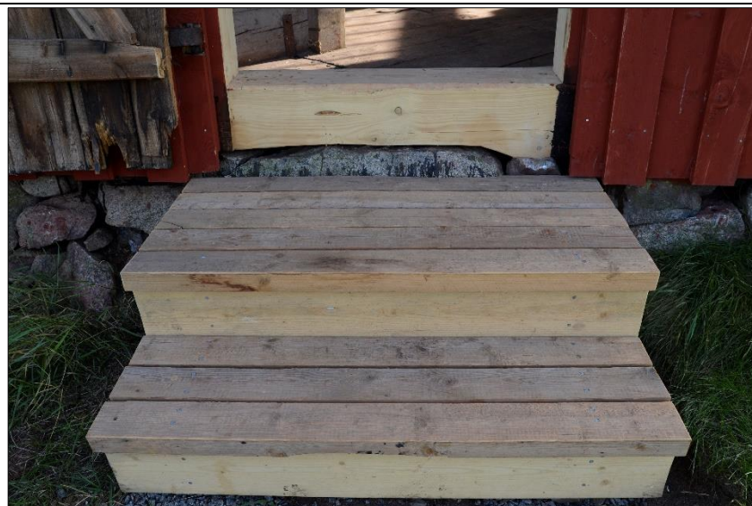
Ny yttertrappa, tröskel och dörrkarm, dörr mot väster. Foto: AP, 2020-09-17
