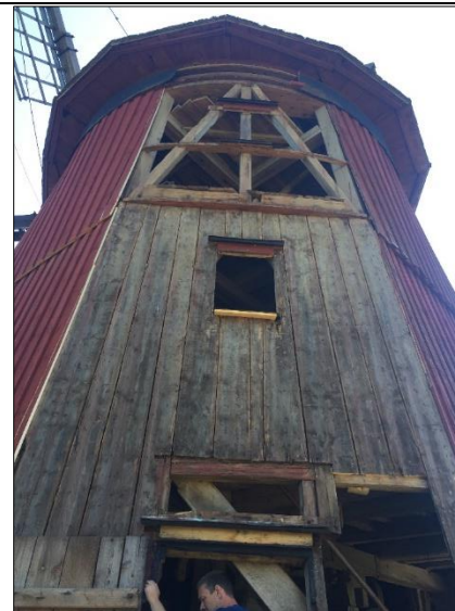
Lockpanelen har demonterats på fasaden mot väster. Foto: Allan Rodbe, 2020-06-12
