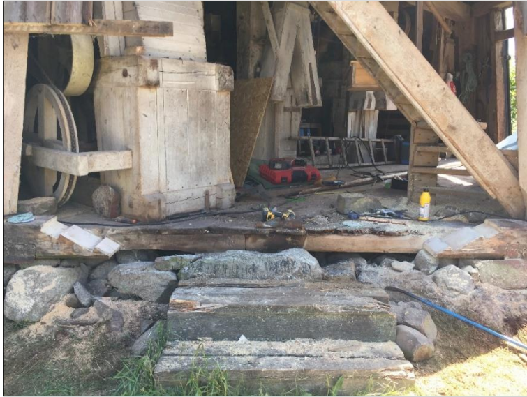
Syllstock lagas i med blixtskarv. Foto: Allan Rodbe, 2020-06-
