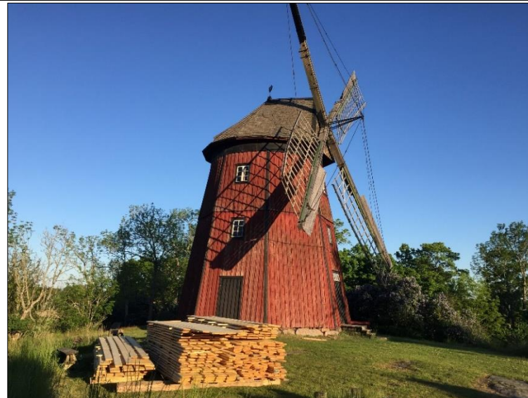
Nya panelbrädor som ska ersätta de befintliga. Foto: Allan Rodbe, 2020-06-03
