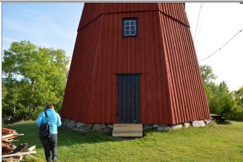
Slutbesiktning av utförda åtgärder, fasaden mot väster. Foto: 2020-09-17
