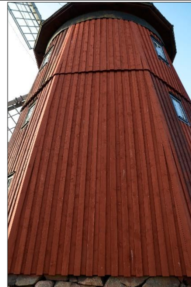
Nya lockpanel på fasad mot norr. Foto: AP, 2020-09-17
