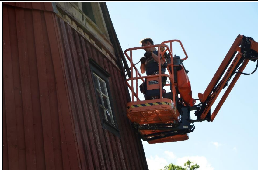
Mikael Wass har påbörjat rivning av lockpanelen mot söder, 2021-06-11
