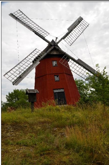
Hättkvarnens sida mot sydväst efter åtgärdande, 2021-07-09
