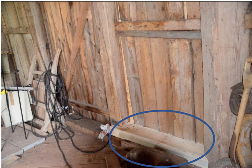
Utförd ilagning av timmerstomme intill enkeldörr mot öster, 2021-07-09
