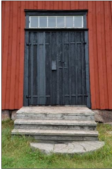
En bräda har ersatts på vänster dörrblad på pardörr mot sydväst, 2021-07-09
