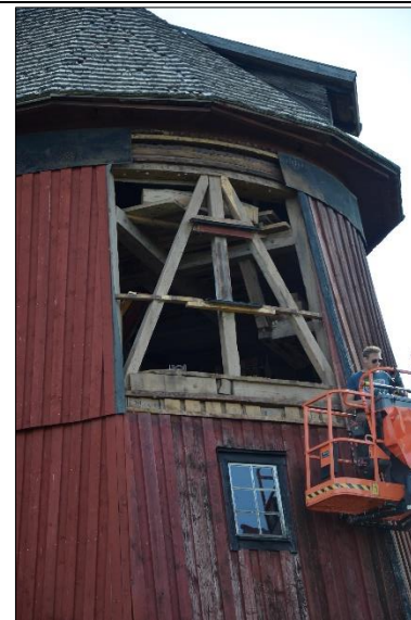
Mikael Wass har påbörjat rivning av lockpanelen mot söder, 2021-06-11
