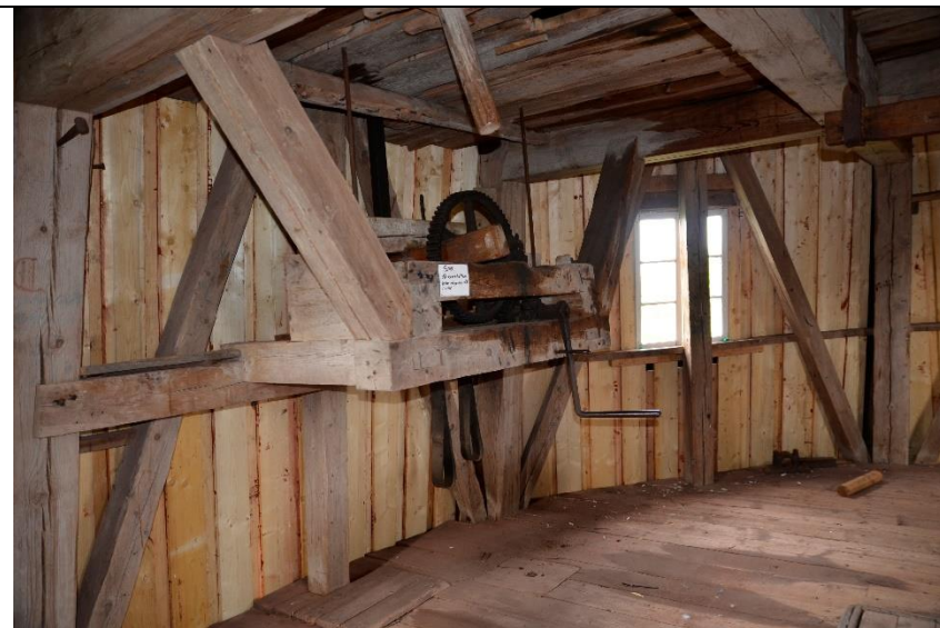
Den nya lockpanelen från insidan, plan 2, 2021-07-09
