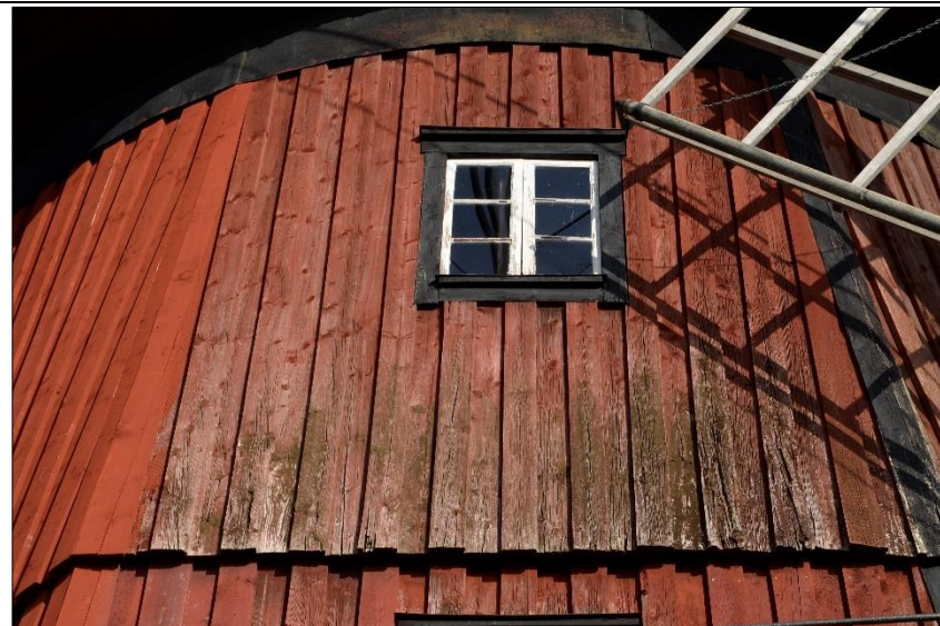
Rötskadad lockpanel mot sydväst, plan 2, 2020-09-17
