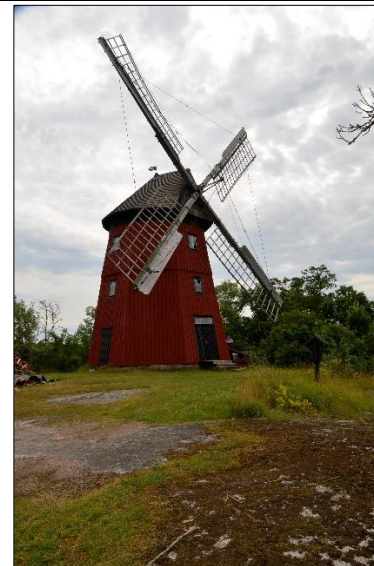
Hättkvarnens sidor mot väster och sydväst efter åtgärdande, 2021-07-09
