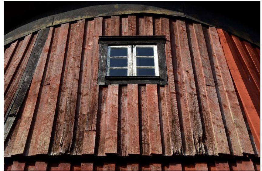
Rötskadad lockpanel mot öster, plan 2, 2020-09-17
