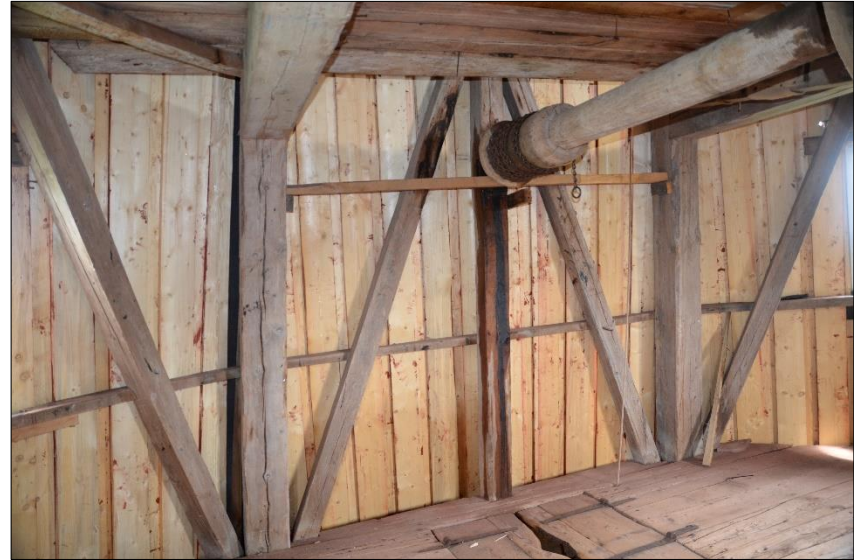
Den nya lockpanelen från insidan, plan 2, 2021-07-09
