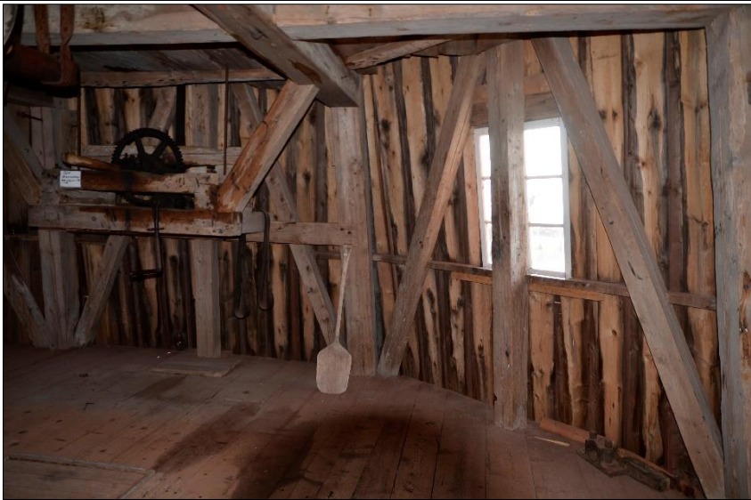
Rötskadad panel, plan 2, 2020-09-17
