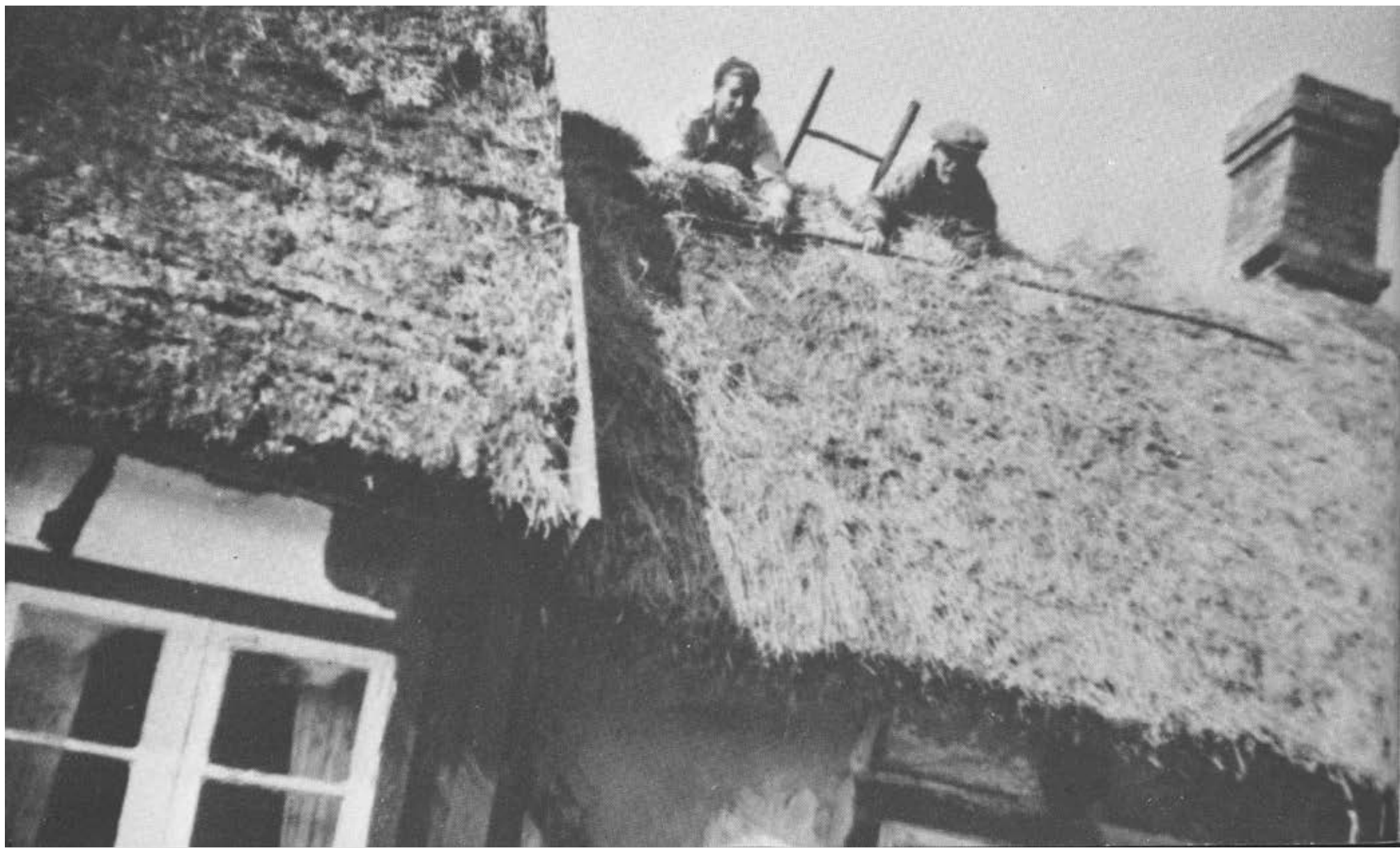
Omläggning av taket på undantagsstugan. Här arbetar Erna och August med ryggningen, taknocken av halm, i slutet av 1940-talet.
